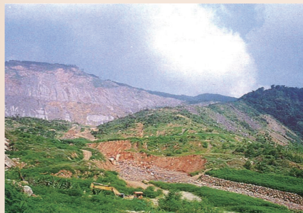
民國88年九二一地震-國姓南港-植生工程施工後草種發芽情景。
