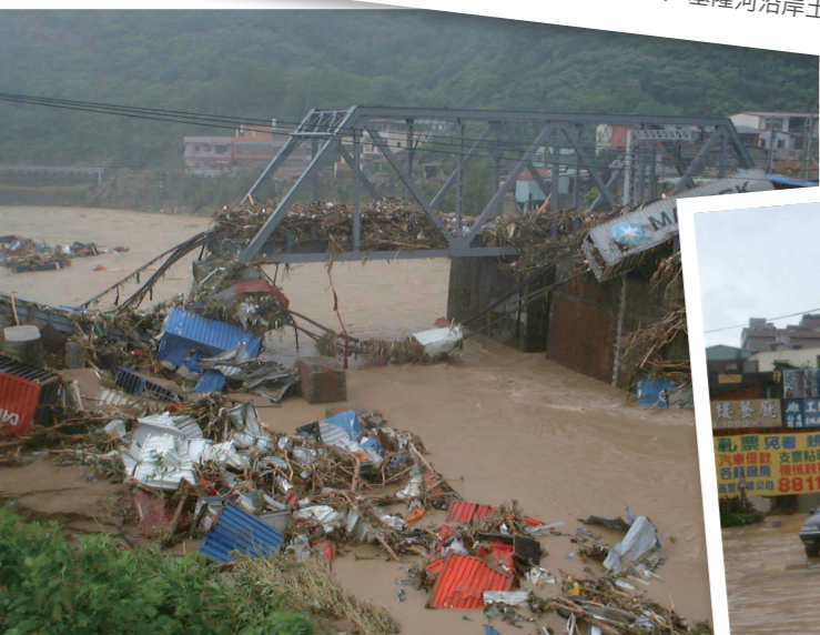
圖8 納莉颱風時貨櫃被沖入河中，阻塞了河道，導致淹水加劇。(李光敦提供)
