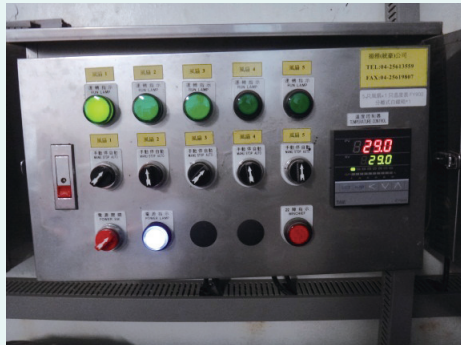
圖28. 水禽舍自動控制系統。
