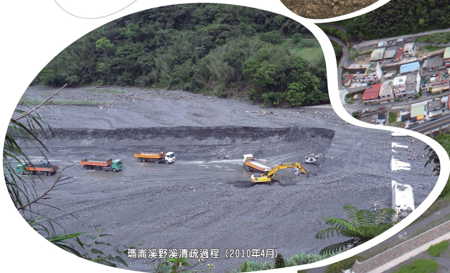
瑪崙橋災後土砂淤積情況
