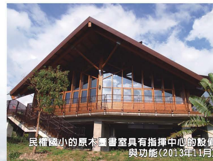
新建綠色鑽石建築民權國小，也是瑪雅里的避難處所(2013年11月)
