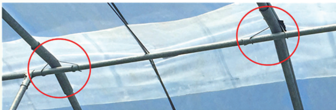
圖2.16 彈簧管夾正負交錯配置
