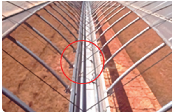
↓圖2.18 天溝內設置結束固定帶用直管
