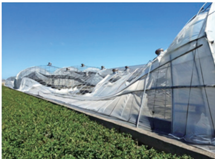
圖6.1 側面橫向力破壞
