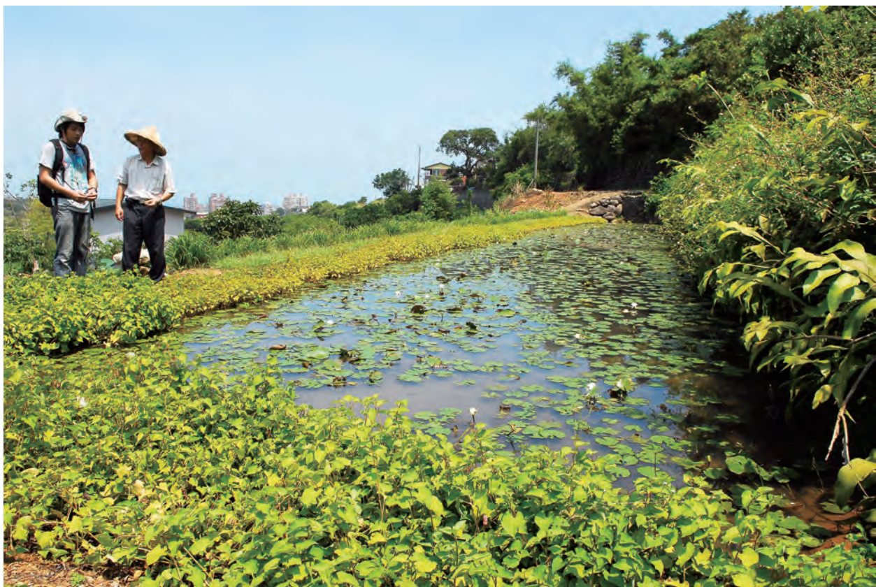
八賢村共榮社區採用簡易的污水排放淨化池，讓大自然分解污水。
