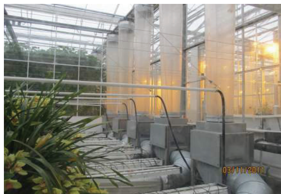
圖 6. 試驗溫室的环境控制裝置
