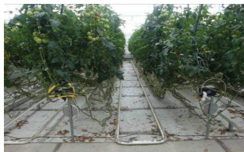
圖 11.軌道式加溫管路
