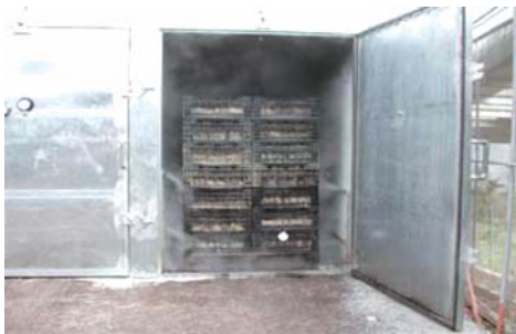
蒸汽機產生之高壓蒸汽導入密閉室內，進行使用過之介質消毒
