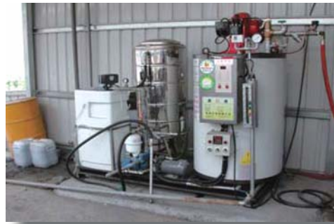
應用蒸汽機產生之高壓蒸汽進行蒸汽消毒
