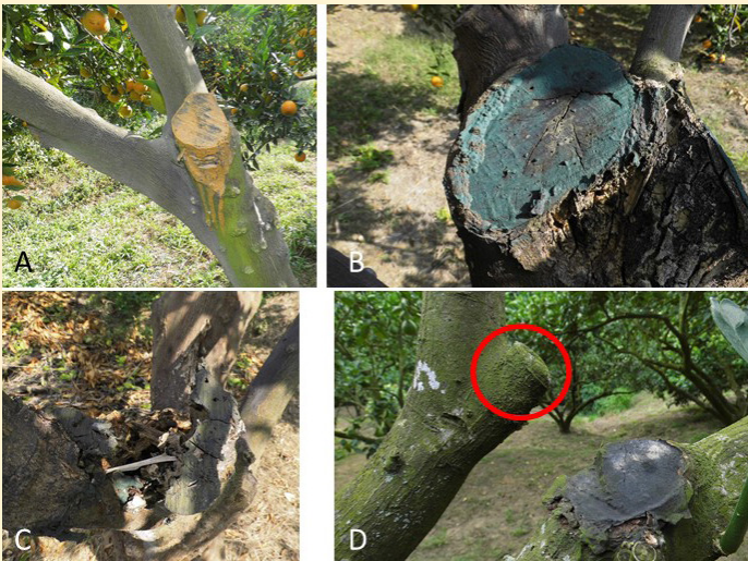
圖七、(A) 截幹傷口塗膠過厚阻礙癒傷組織生長，(B) 修剪錯誤與塗膠傷口沒有辦法癒合並逐漸腐朽，(C) 腐朽後被蟲蛀蝕腐壞，(D) 紅色圈選處為漏掉沒有塗膠反而癒合。
