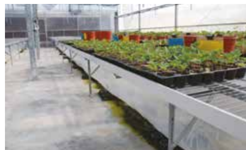
圖 4-15、高效隔離溫室中設置風管正壓系統
