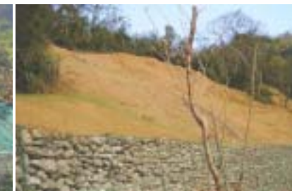
▲宜蘭縣三星鄉 下湖崩塌裸坡地植生復育處理——施工後
