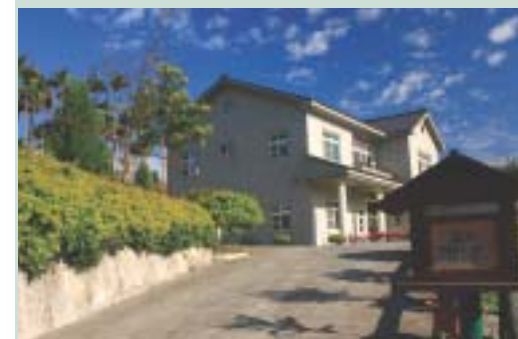
▲南投魚池大雁村農村住宅改善美化
