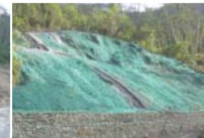
▲宜蘭縣三星鄉 下湖崩塌裸坡地植生復育處理——施工中
