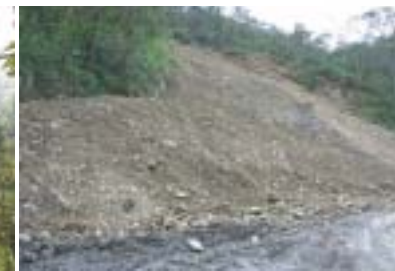
▲宜蘭縣三星鄉 下湖崩塌裸坡地植生復育處理——施工前
