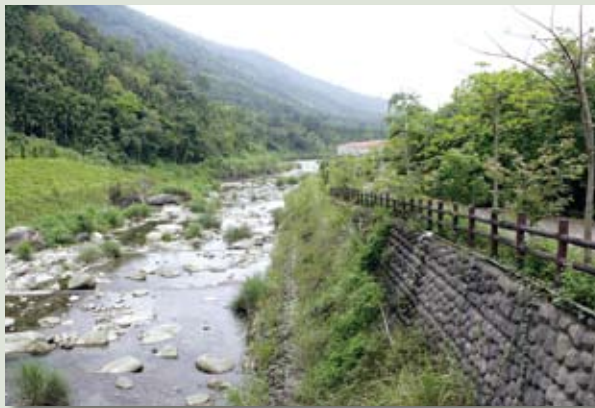
花蓮縣鳳林鎮鳳義水源地整治工程
