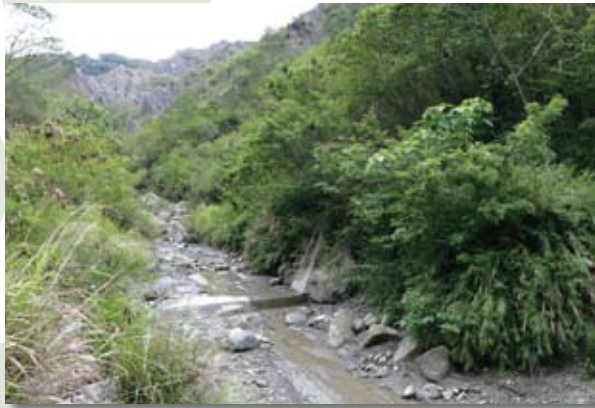
台東縣卑南鄉利吉一鄰野溪整治工程
