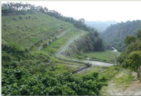
雲林縣林內鄉林北大坑水土保持工程
