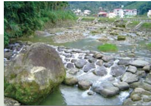
台中縣新社鄉抽藤坑溪中和橋下游整治二期工程
