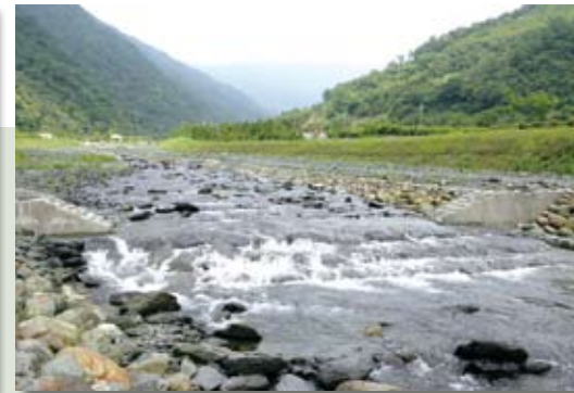
宜蘭縣員山鄉大礁溪上游護岸三期工程
