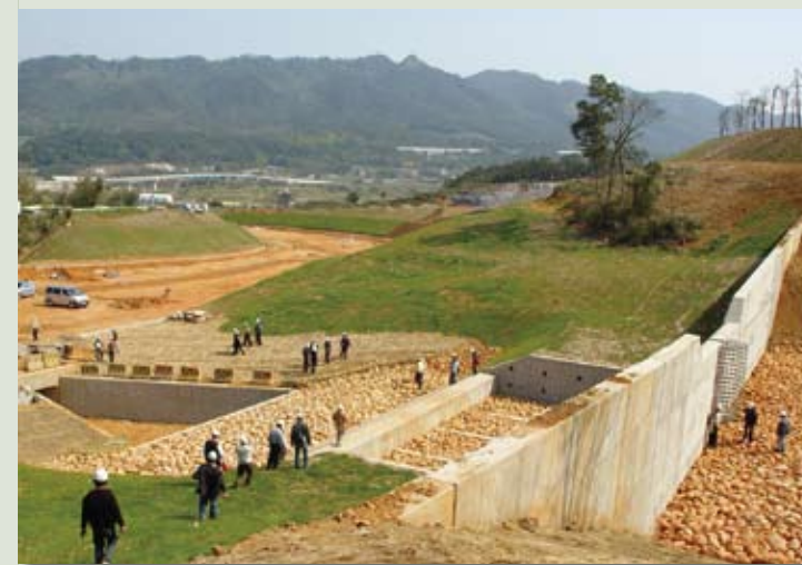
科學園區水土保持設施
