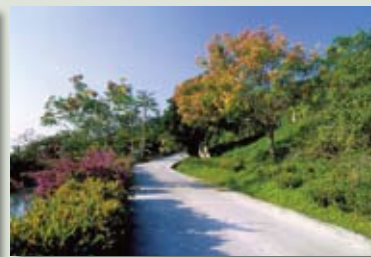
台東東河鄉北郡界道路改善
