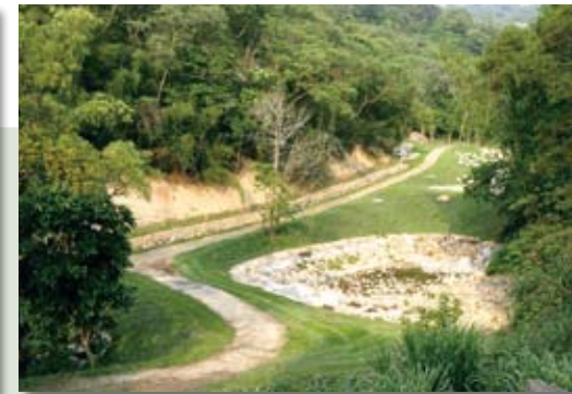
苗栗縣通霄鎮芎蕉坑整治三期水土保持工程
