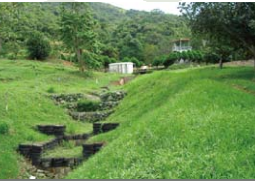
台東賓朗果園輪胎壩、箱型石龍壩、磚砌塊壩等工法
