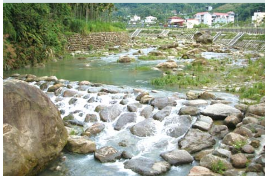
公共工程永續工程暨節能減碳類優等金質獎——得獎工程
