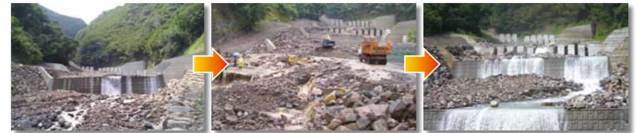
蘇樂溪保育治理工程-9605(完工後)
