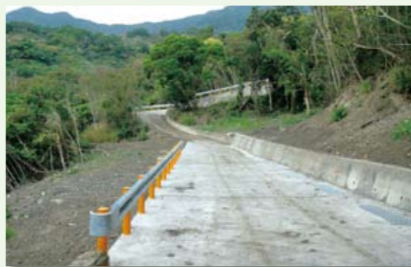
台東縣東河鄉農路改善(改善後)
