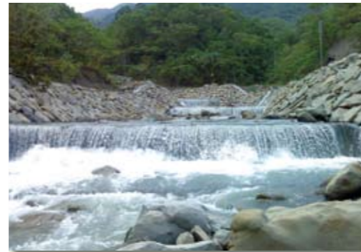
丹路橋上游野溪整治三期工程
