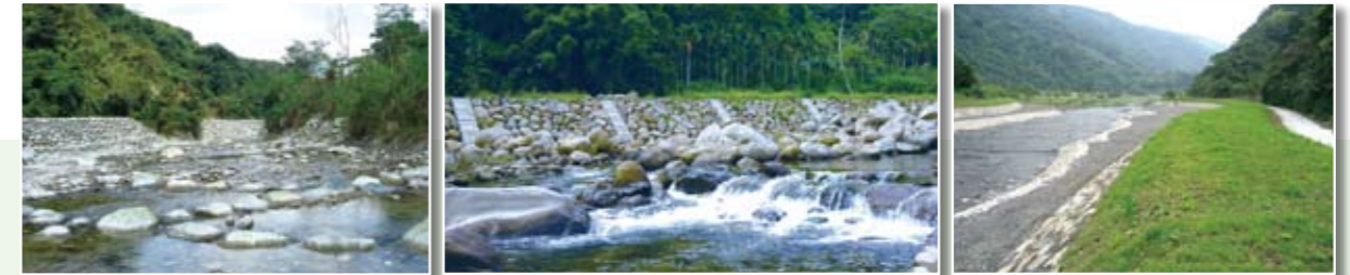
白鮑溪土石災害防治二期工程
