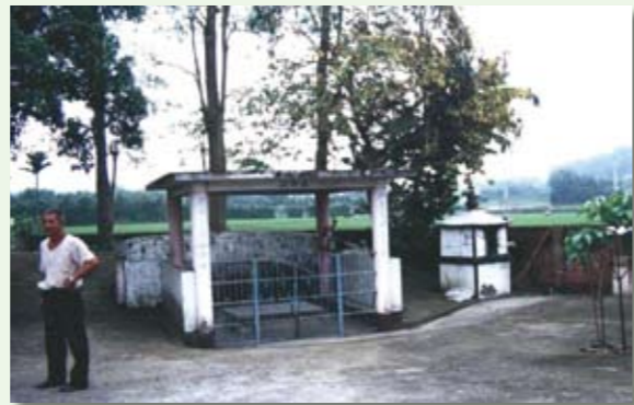
新竹縣北埔鄉南埔社區石爺公-社區參與居住環境改善(空間活化再利用)改善前
