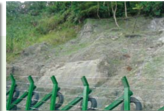
五指山登山步道旁崩塌地處理工程
