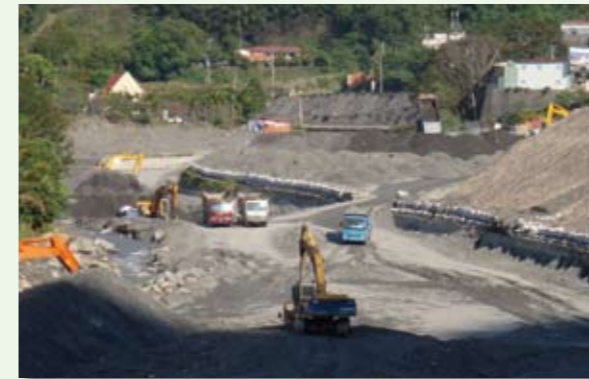
南投縣仁愛鄉眉溪－松林橋下游緊急搶通
