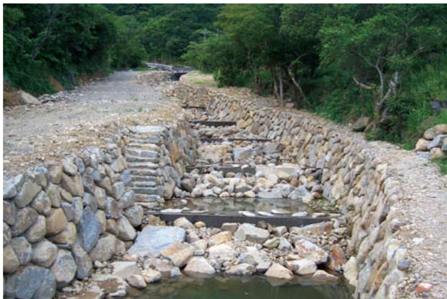
達天員潭溪整治工程
