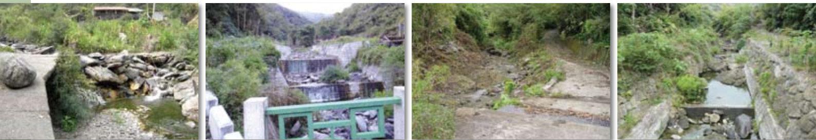
都恩野溪整治工程-前、後
