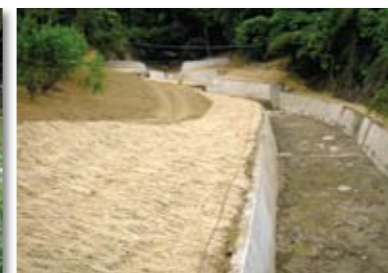
大埔鄉和平村4鄰野溪整治工程
