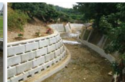
大堀水野溪整治工程
