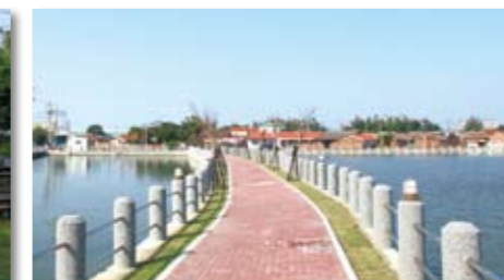
農村再生建設-江山社區環境景觀改善工程-加速辦理地層下陷區排水環境改善示範計畫成果
