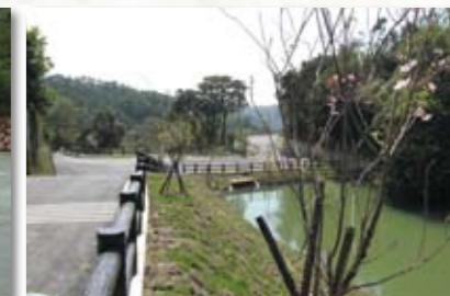
新北鹿鳴農路設施改善工程
