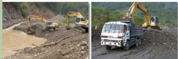
99年度應變期間重機械1級搶修通施工情況
