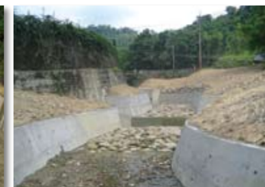
大埔鄉-學坑野溪整治工程
