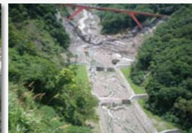
台七線蘇樂橋下游三期土石災害復育工程
