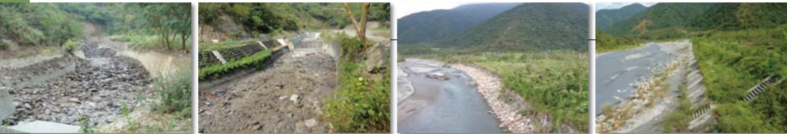
武潭野溪整治七期工程-前、後
