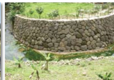
雙溪九份坑野溪災害整治工程
