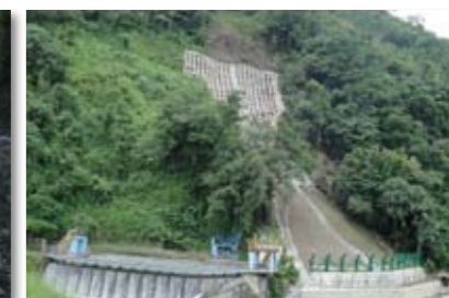
壽豐鄉溪口沉砂池上方崩場地處理二期工程
