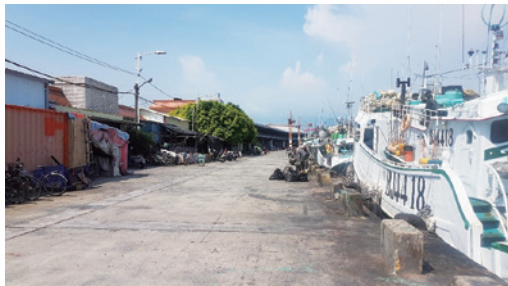
「屏東縣東港泊區北側深水碼頭整建工程」第一階段工區（施工前）
