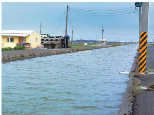
嘉義縣好美里海埔地魚塭集中區排水改善工程（施工前）
