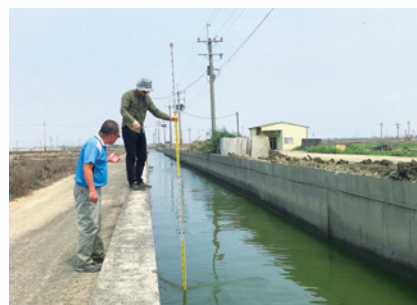
嘉義縣竿仔寮養殖漁業生產區－檢視養殖生產區排水路淤積情形
