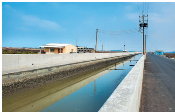
嘉義縣好美里海埔地魚塭集中區排水改善工程（施工後）
