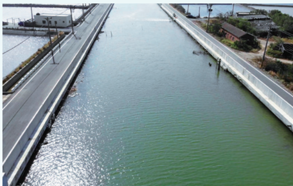
雲林縣下崙養殖區下崙排水改善工程（施工後）
