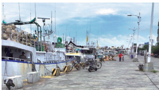
「屏東縣東港泊區南側深水碼頭整建工程」第一階段工區（施工前）
