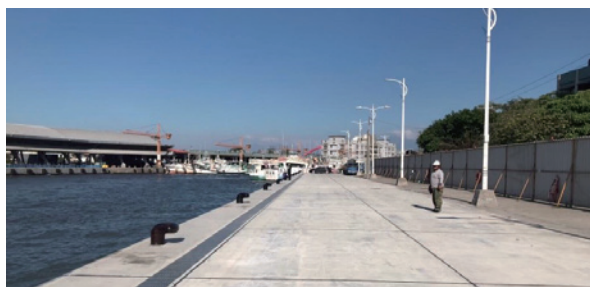
「屏東縣東港泊區南側深水碼頭整建工程」第一階段工區（施工後）
