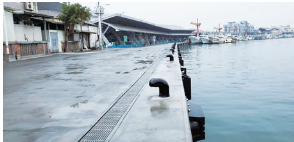
「屏東縣東港泊區北側深水碼頭整建工程」第一階段工區（施工後）
