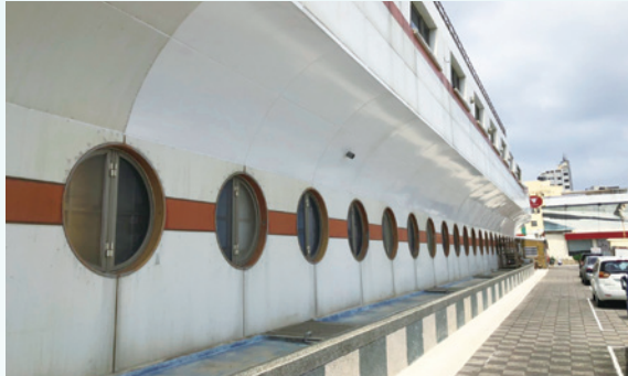
澎湖區漁會第二漁港漁產品直銷中心牆面整修工程
