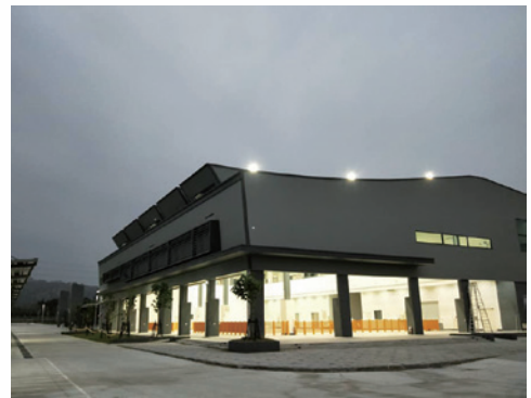
新建完工之岡山魚市場
