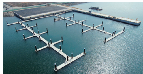
彰化漁港漁筏停泊區及浮動碼頭工程完工空照圖
