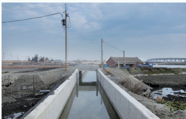
雲林縣羊稠厝大排一中排改善工程（施工後）
