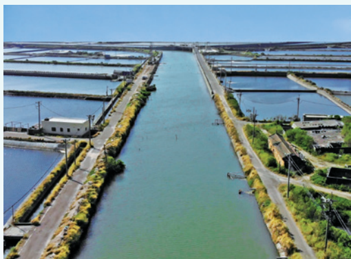
雲林縣下崙養殖區下崙排水改善工程（施工前）
