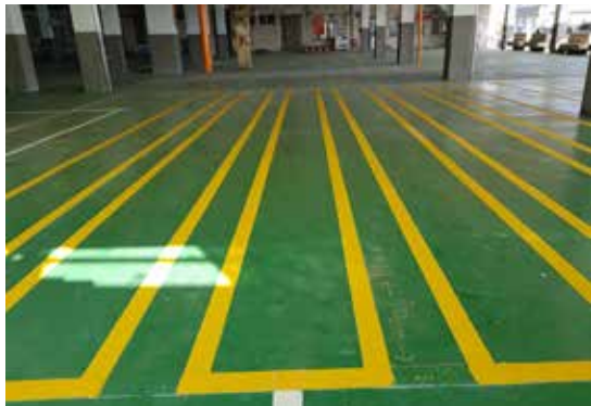
東石魚市場地坪改善，提升魚市場整體環境及生鮮魚貨之衛生安全
