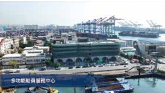
多功能船員服務中心（施工中）
