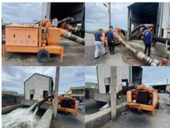
屏東縣大庄養殖漁業生產區移動式抽水機維運管理情形抽查
