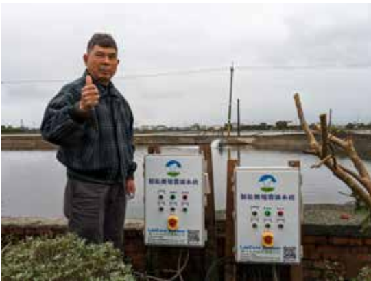
魚塢智慧電箱，可遠端控制增氧機等機具運作
