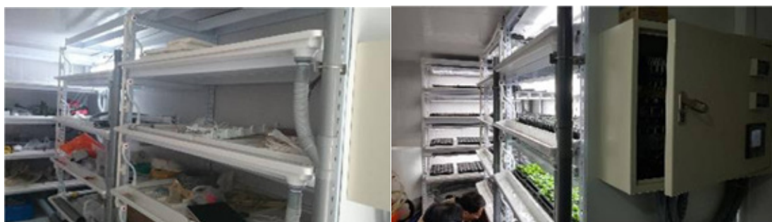
圖 4-8、臺大環控貨櫃內部改建成育苗用(左：施工中，右：栽培中)
