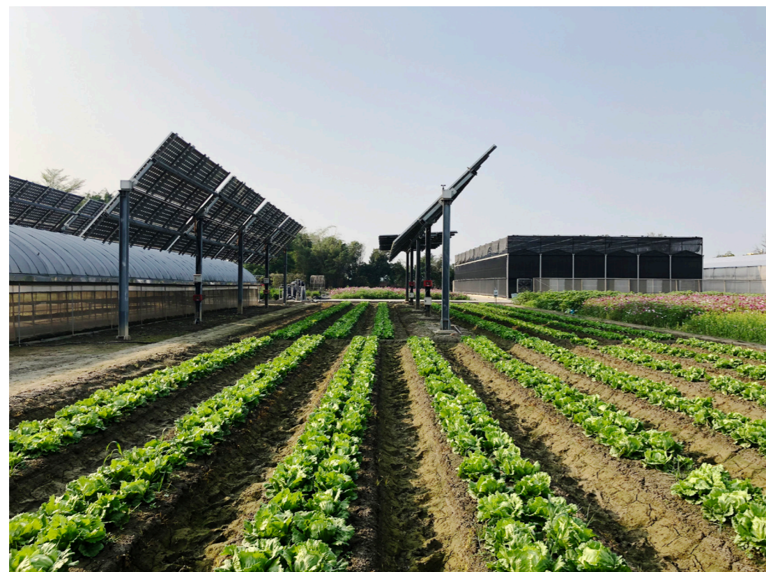
▲ 本場地面立柱式追日型營農型光電設施場域
