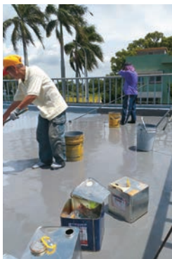
● 民國108年農產加工打樣中心屋頂防水施工情形
