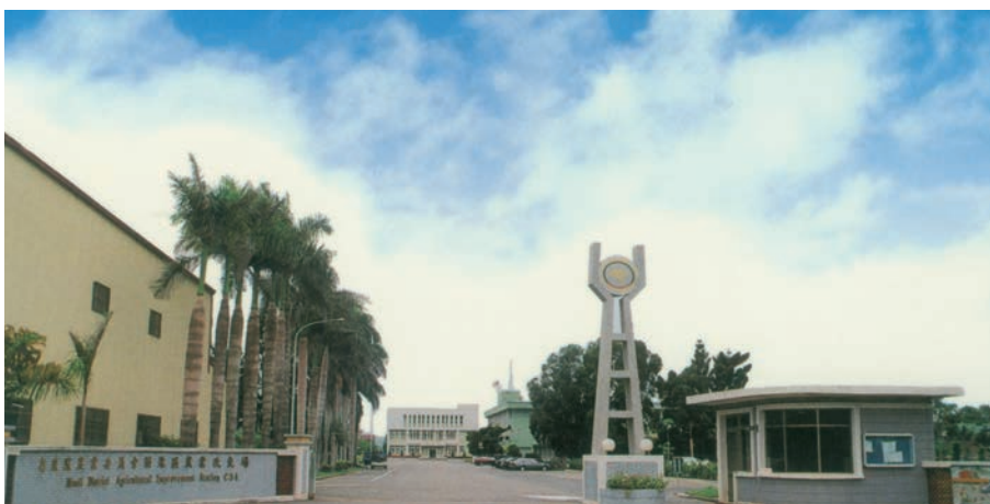
● 民國90年苗栗區農業發展運籌中心建築工程興建前之大門
