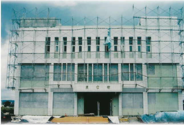
● 農業博覽館~ 施工中
