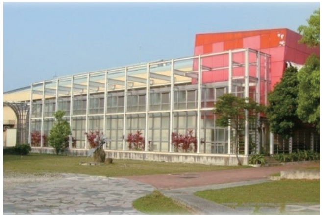
● 生物產業館~ 完工
