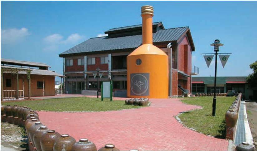
● 釀酒實驗室~完工
