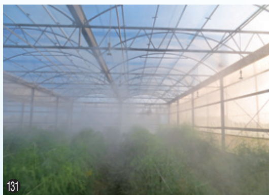
⑬⑩ 設施超音波造霧機運作情形
