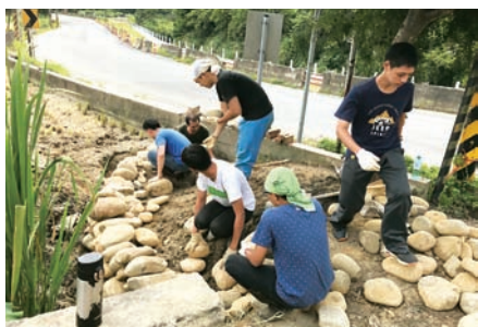
學生在大太陽下為社區農場進行休憩平台和導覽指標的施工。
