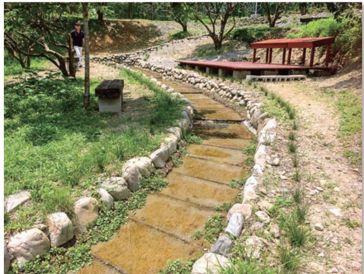
河道魚梯整理完成，營造居民及遊客可親近觀魚的休憩平台
