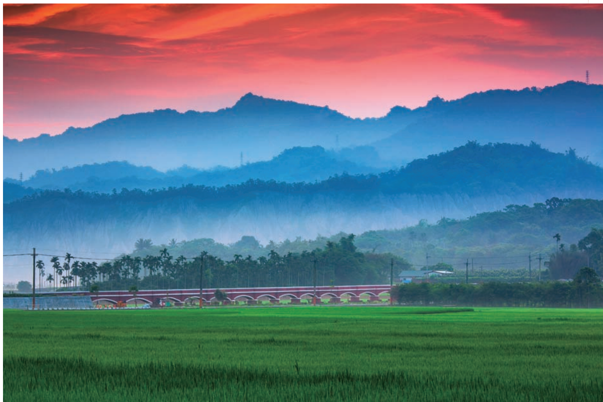
臺東縣鹿野鄉瑞隆村二層坪水橋
