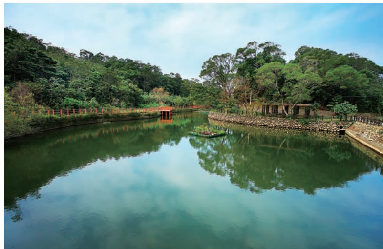
苗栗縣三灣鄉三聯埤三生農塘環境改善工程 (第12屆公共工程金質獎優等獎)
