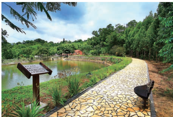
苗栗縣造橋鄉龍昇社區6鄰埤塘周邊環境改善工程
