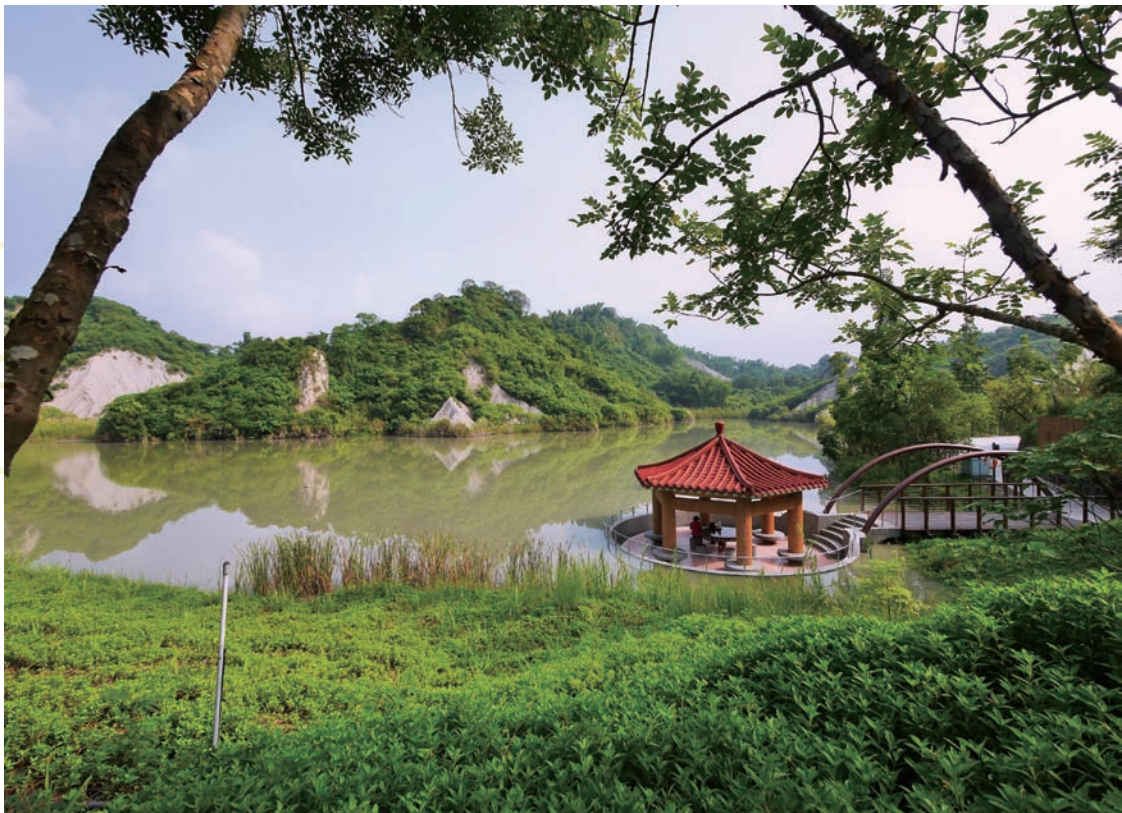
臺南市龍崎區牛埔泥岩水土保持教學園區環境改善工程(第14屆公共工程金質獎佳作)
