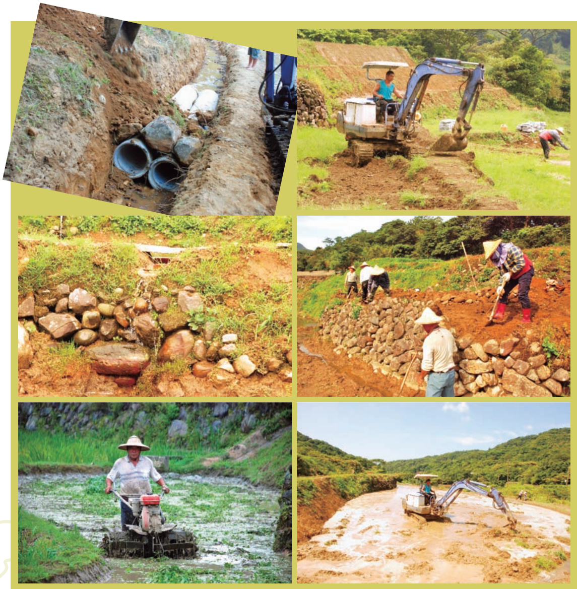
新北市石門區嵩山社區水梯田修復過程
