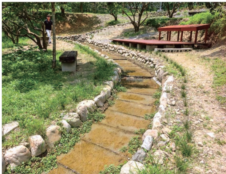
河道魚梯整理完成，營造居民及遊客可親近觀魚的休憩平台
