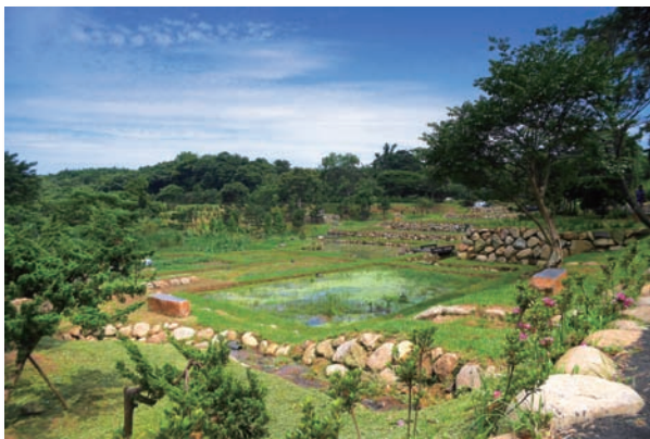
新北市三芝區圓山頂儲水設施周邊環境改善工程
