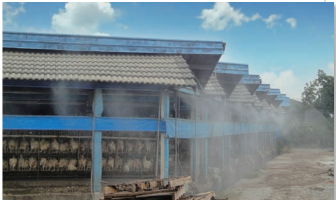
補助畜牧場設置除臭噴霧設施，降低臭味溢散
