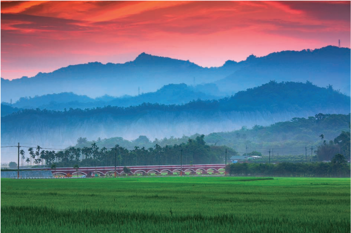
臺東縣鹿野鄉瑞隆村二層坪水橋
