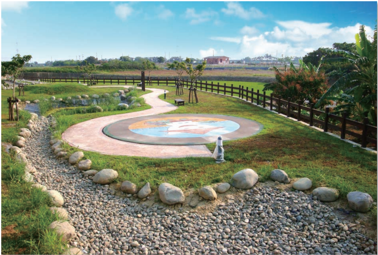
臺南市官田區瓦碓農村社區土地重劃—污水自然淨化設施
