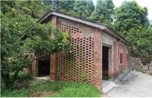
臺中市豐原區公老坪地區洞洞屋陰涼、乾燥、通風為存儲採收之水果的自然建築
