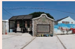
澎湖縣湖西鄉南寮社區 周邊環境改善工程
