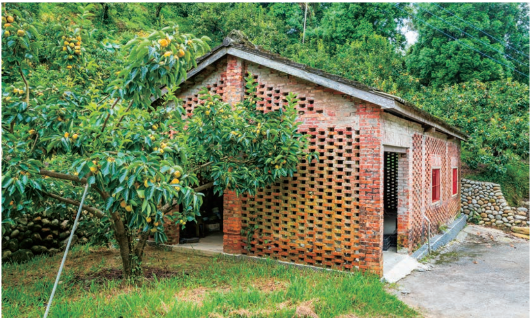
洞洞屋修繕成為社區導覽解說場域
