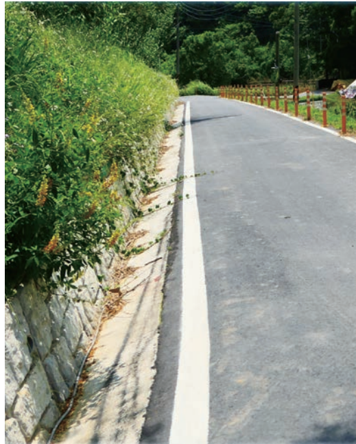
因地制宜，設置 L 型側溝引導流水安全排放
