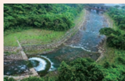
宜蘭縣頭城鎮大溪溪鐵路橋 上游治理工程
