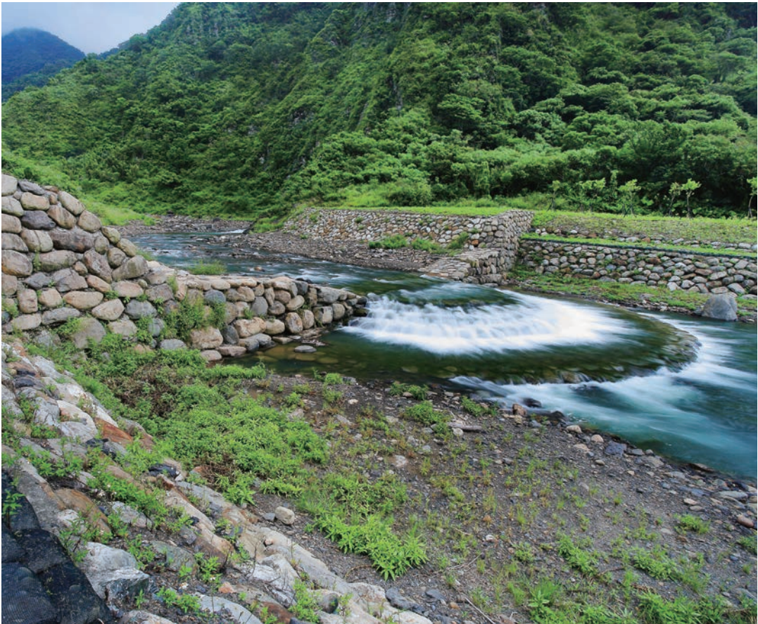
宜蘭縣頭城鎮大溪溪鐵路橋上游治理工程護岸砌石就地取材
