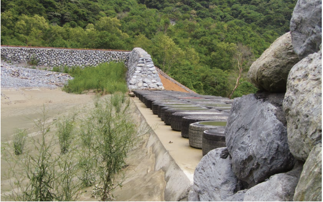
溢洪口輪胎保護
