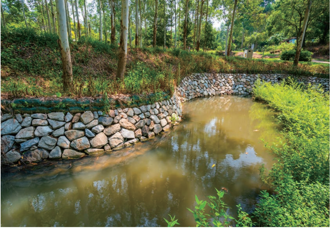
苗栗縣造橋鄉龍昇社區核心園周邊環境改善工程，護岸多孔隙提供動植物生長棲息
