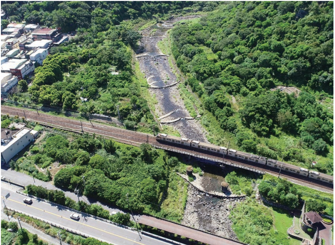
108 年空拍，工程完工成功保護聚落與重要交通設施安全，兩岸植生復育良好
