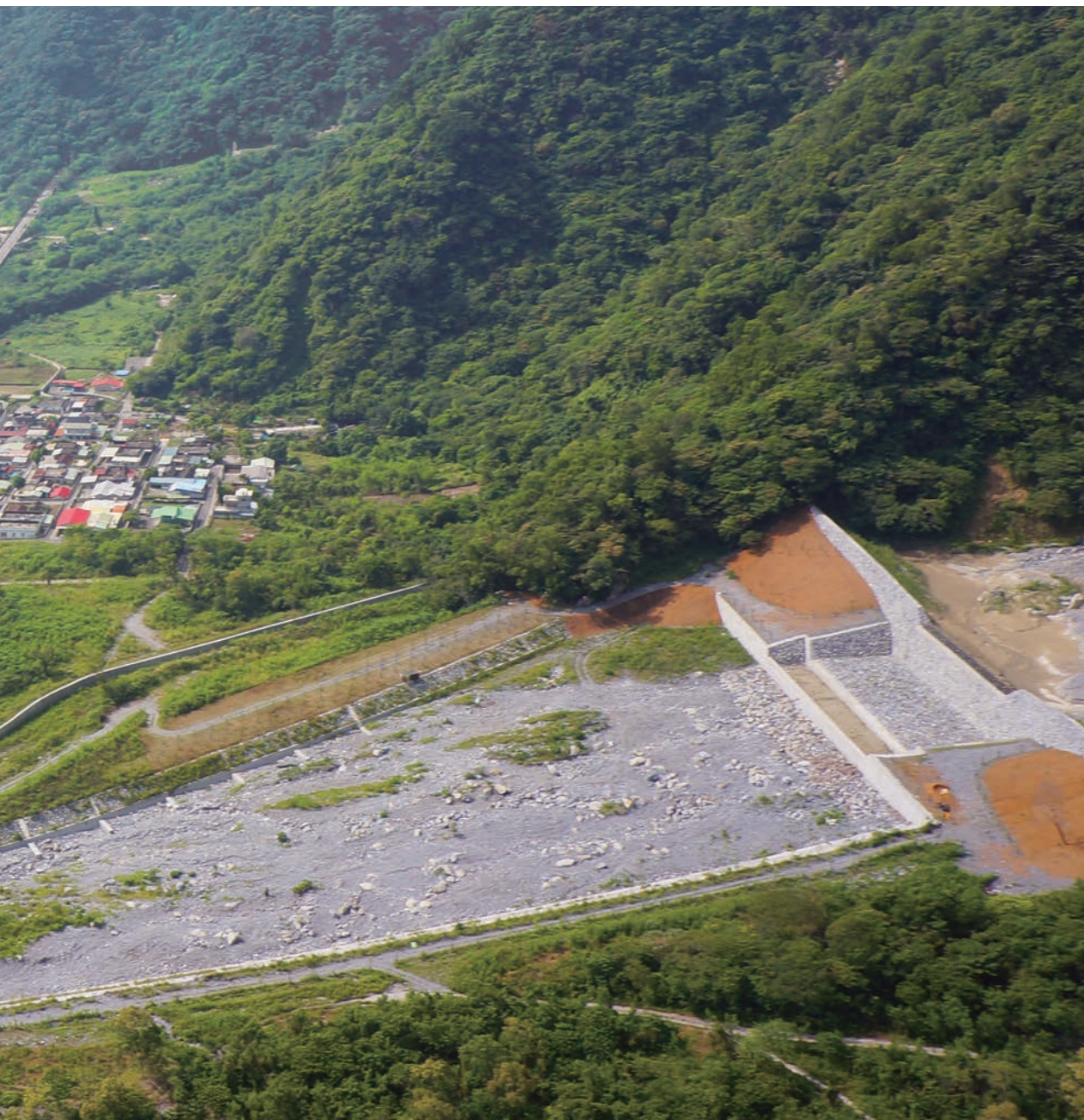
和中部落北側野溪上游土石防治
