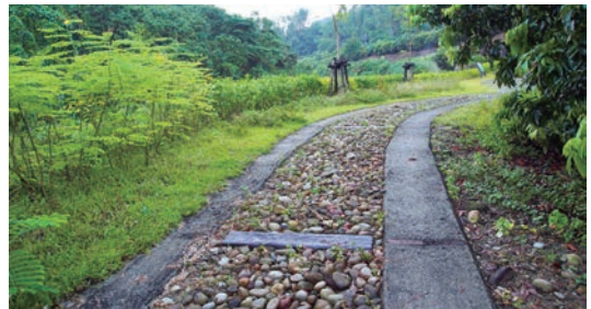
高雄市大樹區統領社區產業步道設施減量中間鋪設碎石
