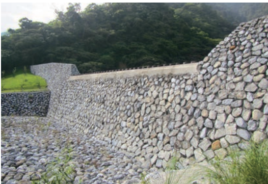
壩面層砌石線型平整
