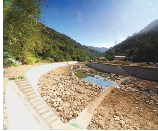
臺中市新社區抽藤坑溪整治工程曲面弧形護岸創新設計，可調整凹岸流場、穩定水流、減少沖刷、加寬緩衝帶
