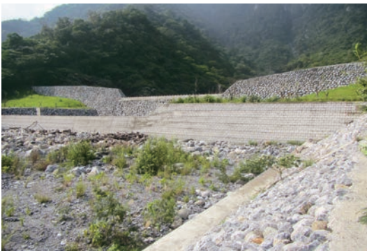
102年完工後防砂壩與緩坡砌石護岸
