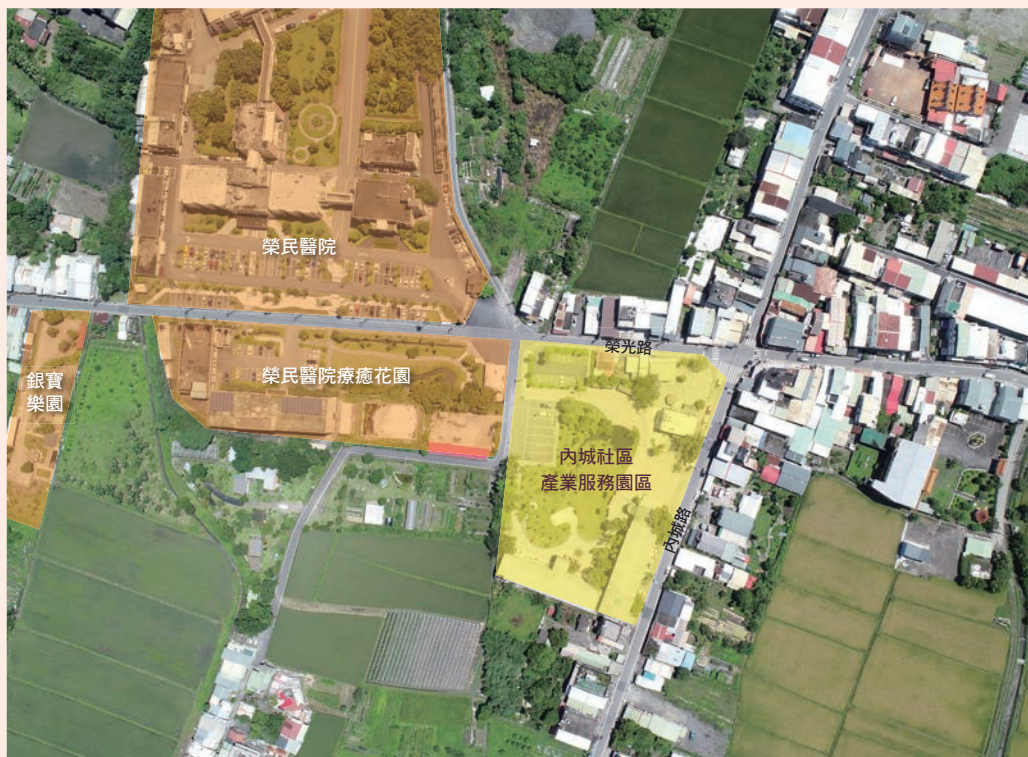
宜蘭縣員山鄉內城社區產業服務園區環境改善工程重點為舊內城國小空間活化
