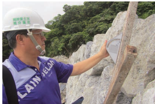
即時調整塊石面層，遠較模板更貼近自然
