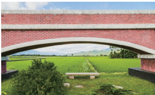
拱形橋提供通道便利居民穿越增加通透性
