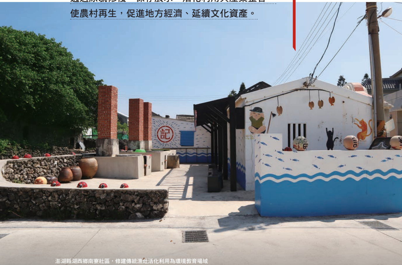
澎湖縣湖西鄉南寮社區，修建傳統漁灶活化利用為環境教育場域
