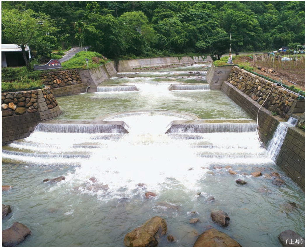
臺中市新社區抽藤坑溪整治工程不同河段之工程設計 (上游)設置弧形護岸保護、配置固床工調整坡降穩定溪床／(中游)凹岸河道放寬、設置分流道、設計深潭與水流緩衝區(下游)／配置固床工調整坡降穩定溪床，創造淺瀨提供生物棲息
