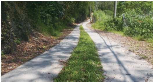
南投縣仁愛鄉南豐社區人車共用通學步道設施減量車道中間留設植生帶
