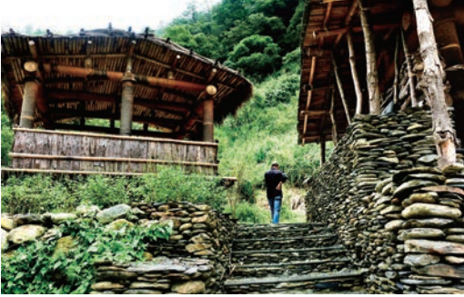
南投縣仁愛鄉南豐社區重現賽德克族半石半木造傳統家屋
