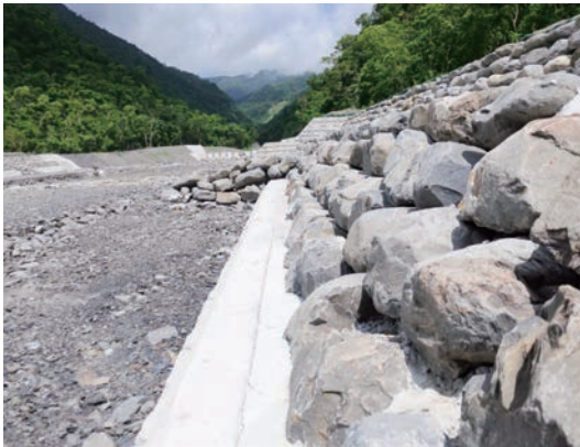
臺東縣仁達鄉台坂溪野溪梳子壩、固床工、砌石護岸皆大量選用現地石塊構築
