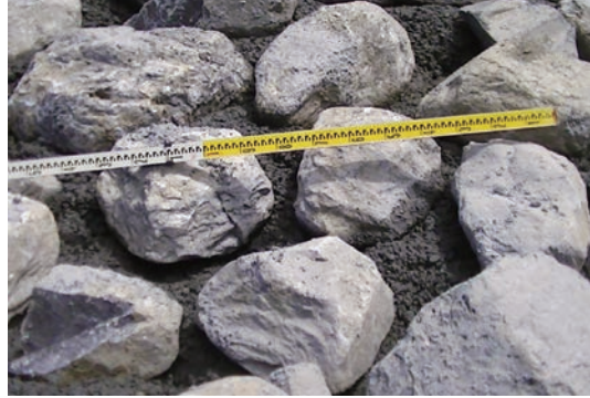
掌控石塊間距，嚴格控制施工品質
