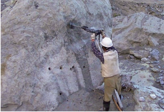
裂解堅硬巨石，施作過程挑戰性大
