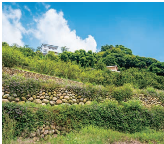
108年砌石牆植生覆蓋
