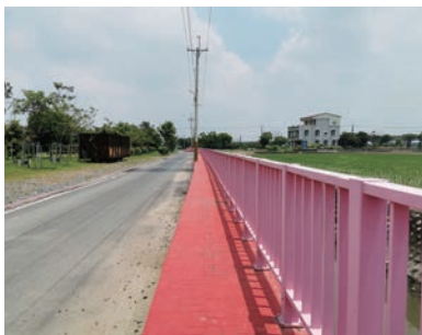
臺南市後壁區仕安轉運站周邊道路架設懸臂版擴充人行道，並設置鍍鋅欄杆維護行人安全
