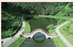
花蓮縣光復鄉馬太鞍吉利潭 周邊環境改善工程
