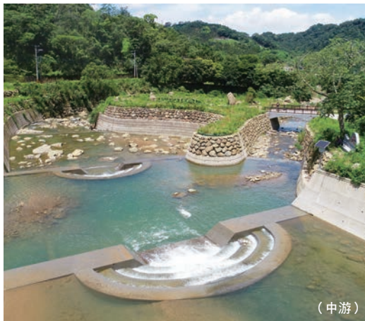
臺中市新社區抽藤坑溪整治工程不同河段之工程設計 (上游)設置弧形護岸保護、配置固床工調整坡降穩定溪床／(中游)凹岸河道放寬、設置分流道、設計深潭與水流緩衝區(下游)／配置固床工調整坡降穩定溪床，創造淺瀨提供生物棲息
