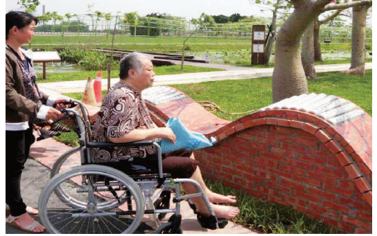
雲牆陶製詩冊採15度斜面設計，符合兒童與輪椅族閱讀視角
