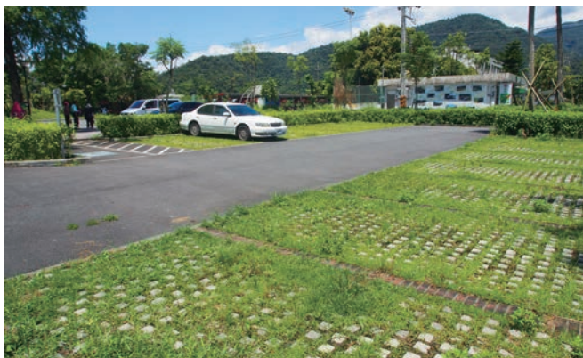
透水鋪面停車場
