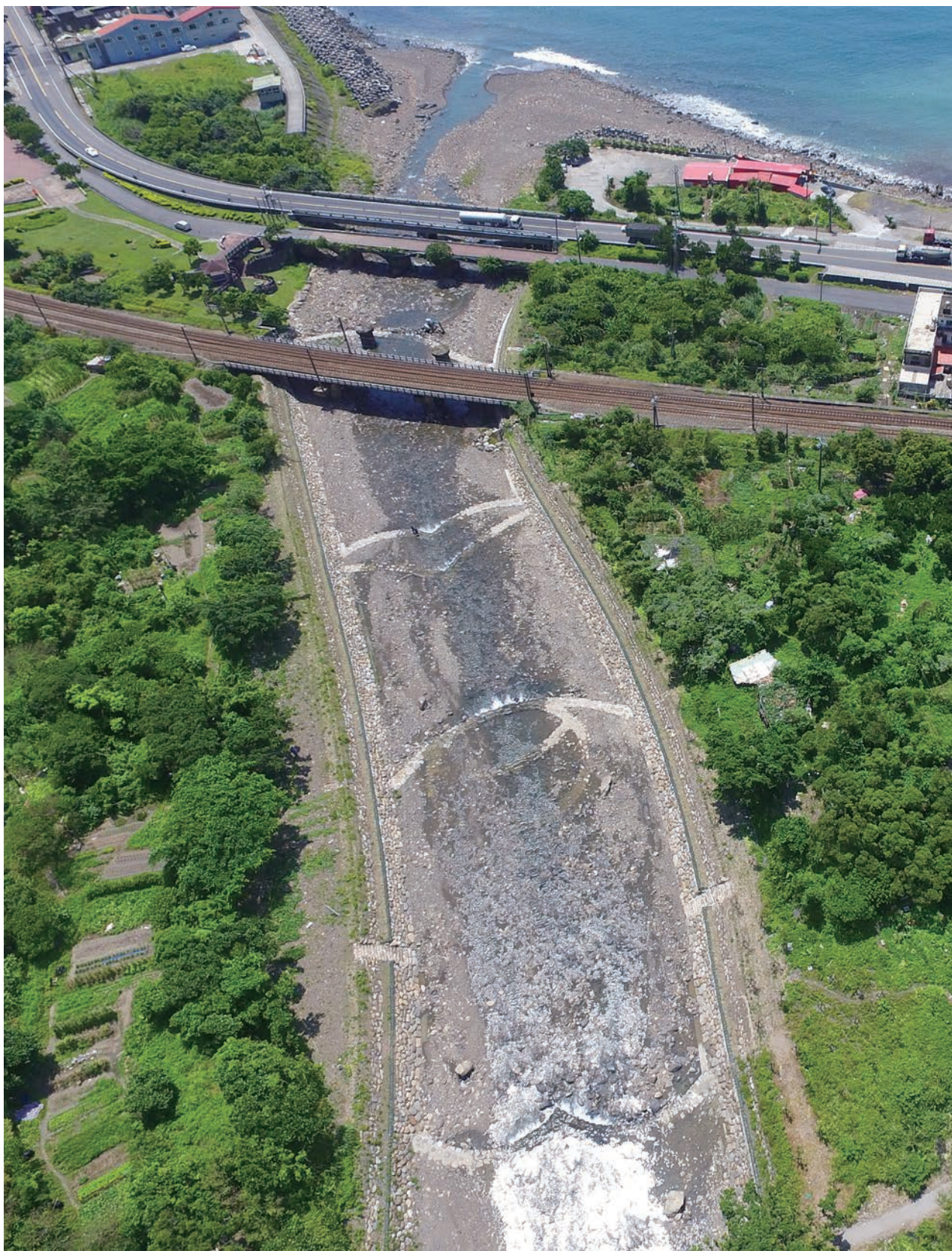
大溪溪鐵橋上游治理
