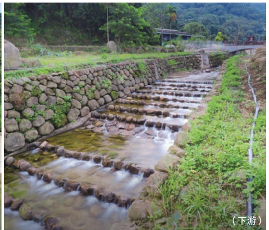
臺中市新社區抽藤坑溪整治工程不同河段之工程設計 (上游)設置弧形護岸保護、配置固床工調整坡降穩定溪床／(中游)凹岸河道放寬、設置分流道、設計深潭與水流緩衝區(下游)／配置固床工調整坡降穩定溪床，創造淺瀨提供生物棲息
