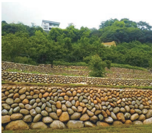
107年砌石牆完工
