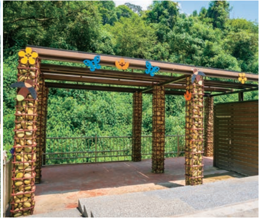
臺中市豐原區公老坪地區運用傳統砌石工法塑造生產地景，設施亦選用卵石以柔化視覺景觀
