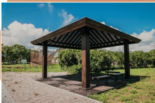
光點亭非全覆蓋式的屋頂，具有增加採光、通風、散熱以及分散風壓的優點／顏歸真攝
