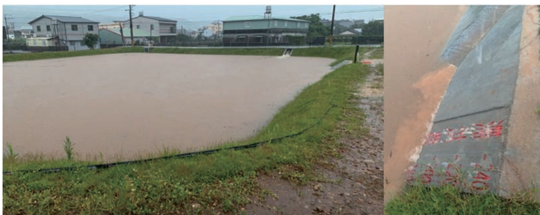
圖 9-5、滯洪農塘之實際滯洪情形
