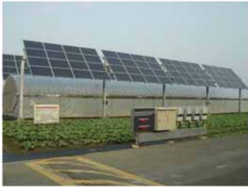
太陽能發電系統結合設施生產
