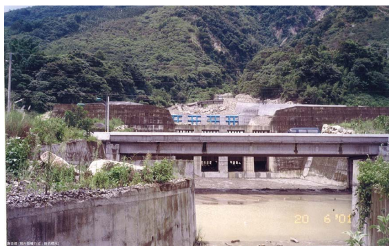
豐丘土石流治理工程配置近景（藍色部份為透性鋼管壩） 照片來源：水保一甲子 - 歷史影像平台 / 謝金德提供
