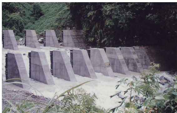
花蓮縣榕樹部落梳子壩 照片來源：《滴水培土—守護大地一世情》，民國 102 年
