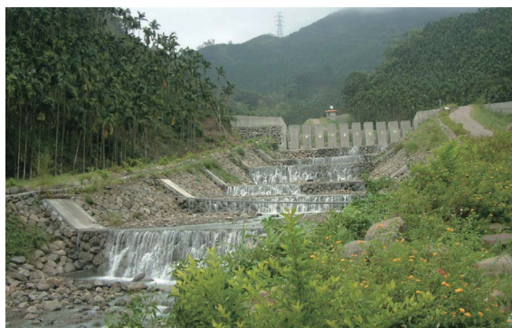
華山土石流教學園區 照片來源：水土保持局
