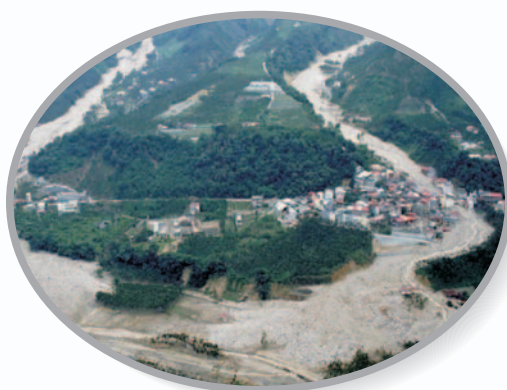
南投縣水里鄉二廊坑溪及三廊坑溪 扇狀地 (90.7.30 桃芝颱風)
