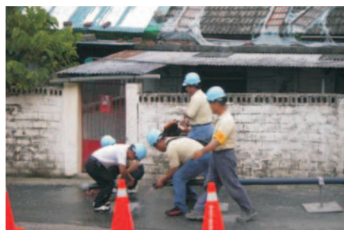
維生管線修復
