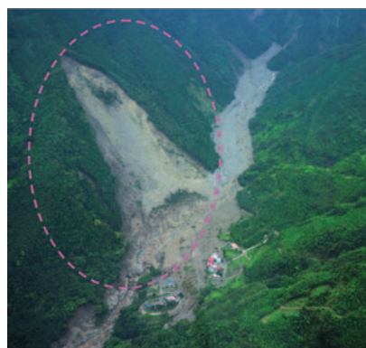
土場部落崩塌災害（9 死 13 失蹤）
