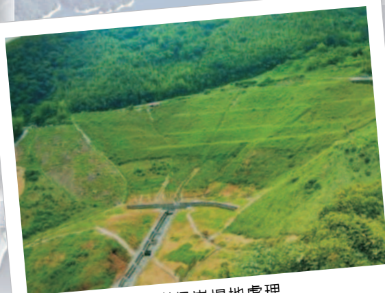
砂崙仔崩場地處理
