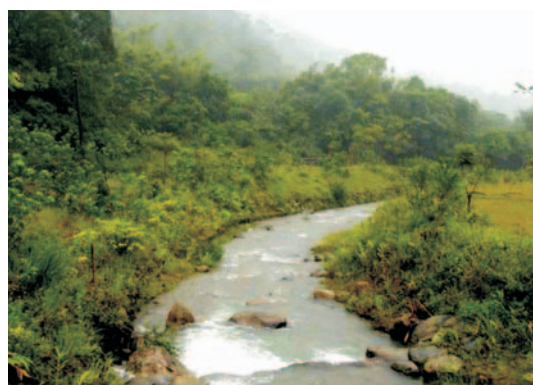
后番子坑溪生態工法治理
