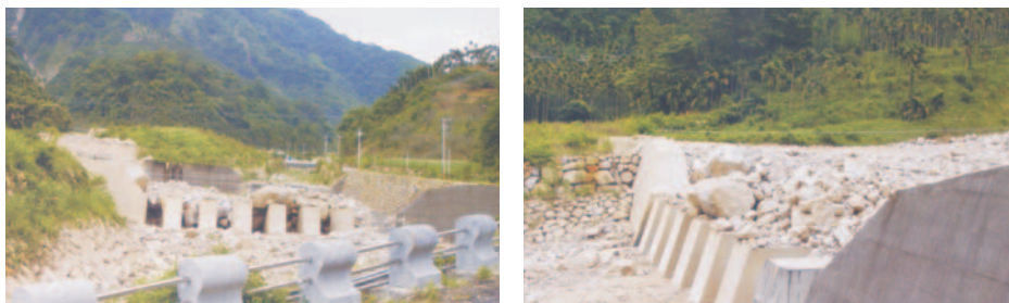
95 年 0609 豪雨上游梳子壩有效控制土砂運移 水土保持工程整治
