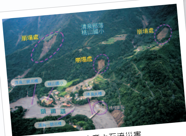
桃山國小旁土石流災害
