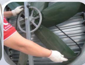
步驟二 拆下皮帶後繞過葉片軸心
