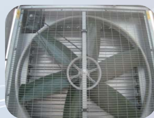
步驟一 拆下防護鐵網
