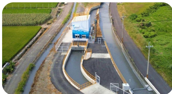
▲ 本部農田水利署雲林管理處鹿場課訓小水力發電廠
