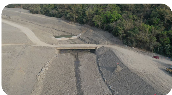
▲ 崩坪坑崩塌地處理 2 期工程野溪清疏辦理情形
