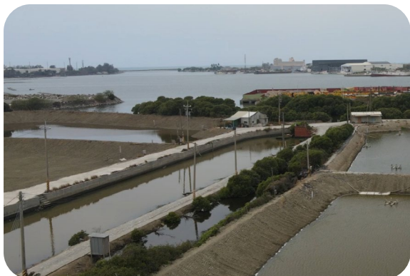
▲ 高雄市興達養殖漁業生產區湖內排水二中排改善工程（施工前）
