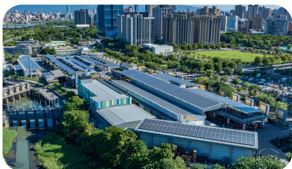
▲ 新北市板橋果菜市場屋頂建置太陽光電，隔絕太陽直射建物，減少室內空調能耗
