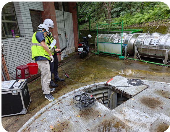
▲ 梅花大規模崩塌潛勢區維護管理
