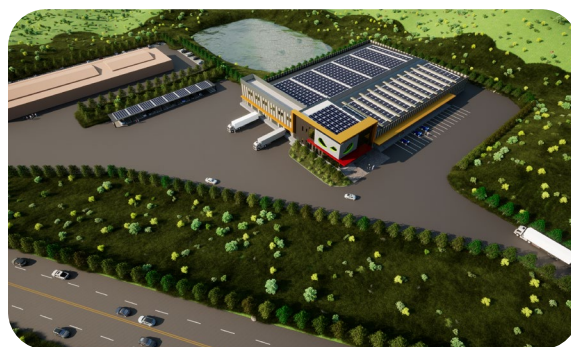
▲ 輔導設置玉井農產加工及冷鏈物流中心為全國最大低溫檢疫區
