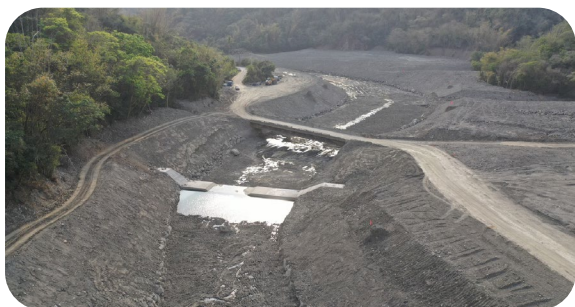
▲ 崩坪坑崩塌地處理 2 期工程野溪清疏辦理情形
