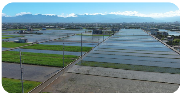
▲ 壯東古亭中排（第 2 期）改善工程，完工後提升排洪效能
