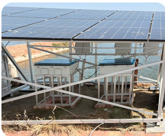
▲ 漁戶建構綠能自發自用，分擔魚塭用電，降低用電成本及作為備援電力
