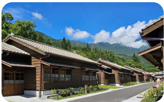
▲ 林田山林業文化園區房舍修復及再利用第 2 期工程完工成果
