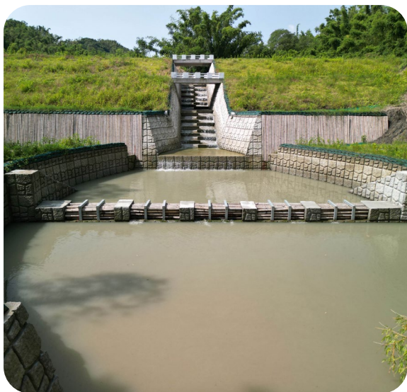
▲ 玉井區第 101 林班草山坑內防砂治理工程
