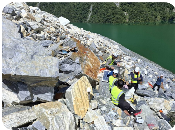
▲ 於馬太鞍溪堰塞湖壩頂裝設水位計
