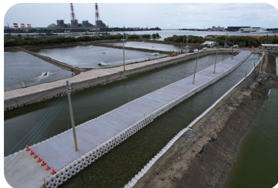
▲ 高雄市興達養殖漁業生產區湖內排水二中排改善工程（施工後）
