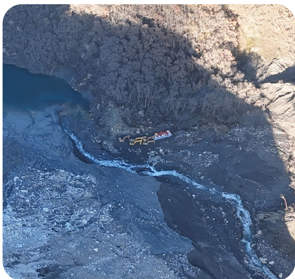
▲ 本部林業及自然保育署花蓮分署利用非汛期期間執行馬太鞍溪堰塞湖壩體降挖工作
