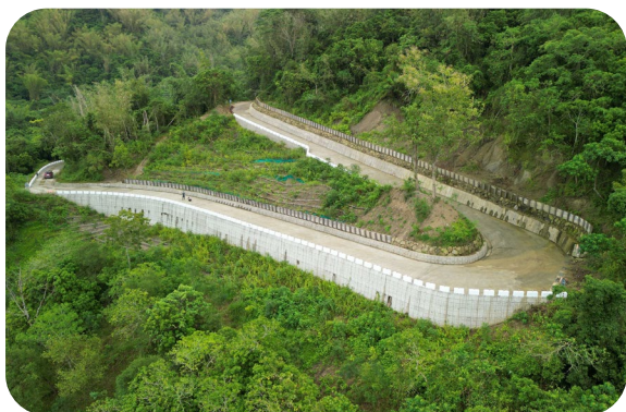
▲ 南山林道修復及周邊崩場地整治 1 期工程
