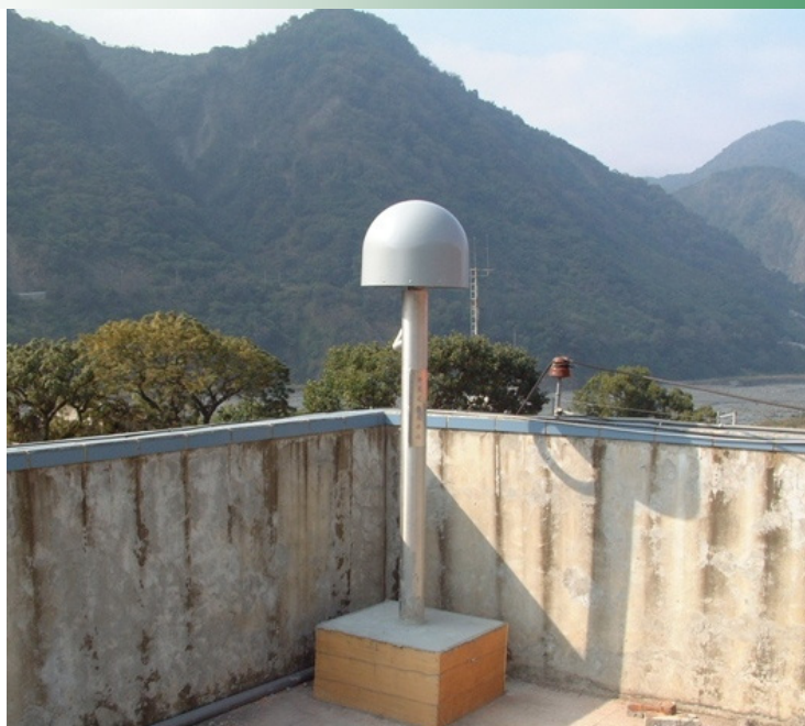
圖 5-2.9 e-GPS 基準站現況圖 (以信義站 SINY 為例)
