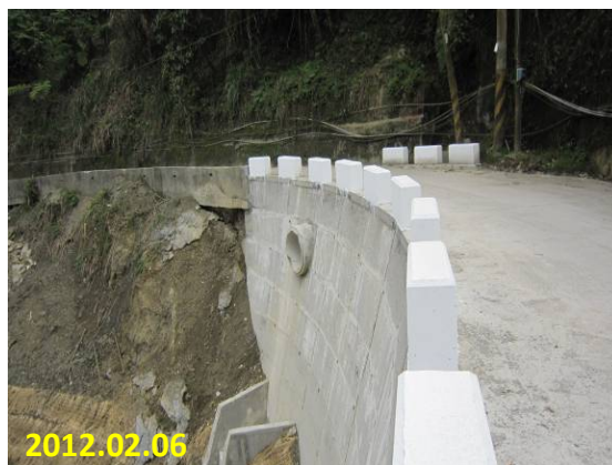
照片 5-18 箱涵 (農中東 024-隆興里石角小段上木浪坑農路改善工程)
