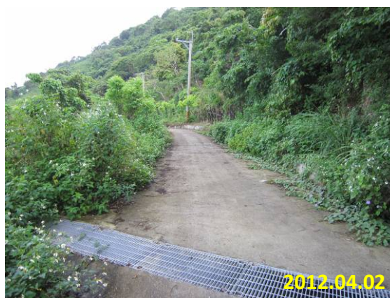
照片 5-53 橫向排水 (農東卑市 057-農東卑 057 及鄰近農路設施改善工程)
