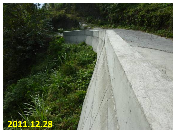
照片 5-16 下邊坡擋土牆 (農中太新 021-自強農路改善二期工程)
