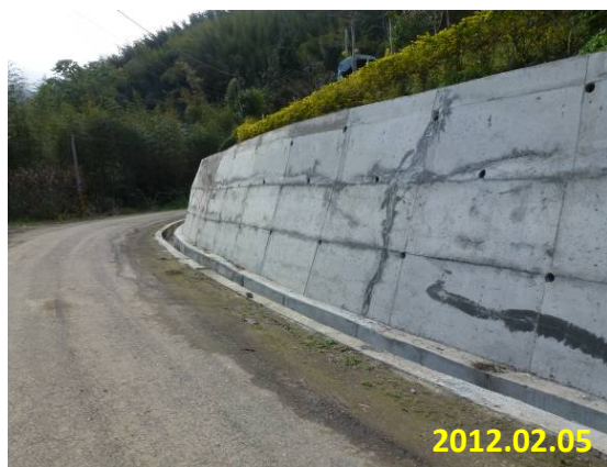
照片 5-1 上邊坡擋土牆 (農竹五 005-農改場新峰農路設施改善工程)
