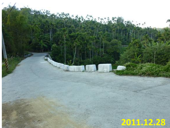
照片 5-25 塊狀護欄 (農中太 002-七瑤農路改善工程)
