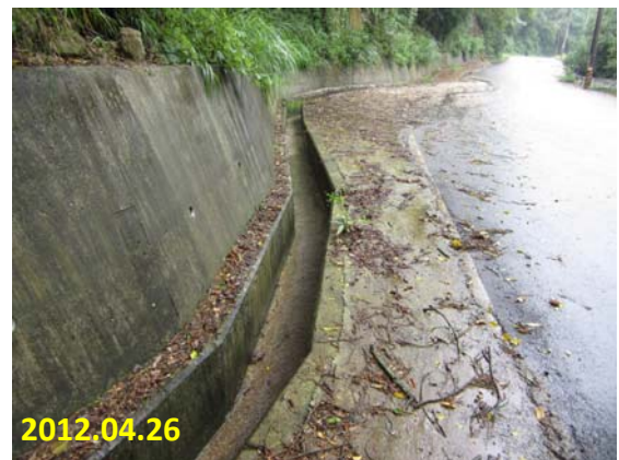
照片 5-71 苗栗縣公館鄉-南河村 4 鄰農路 (邊坡及排水溝整理-排水溝雜草清除)
