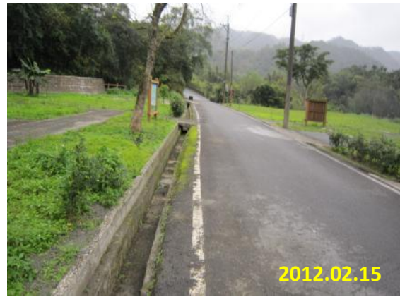
照片 5-69 新北市雙溪區-水銀礦舊址農路 (邊坡及排水溝整理-排水溝雜草清除)
