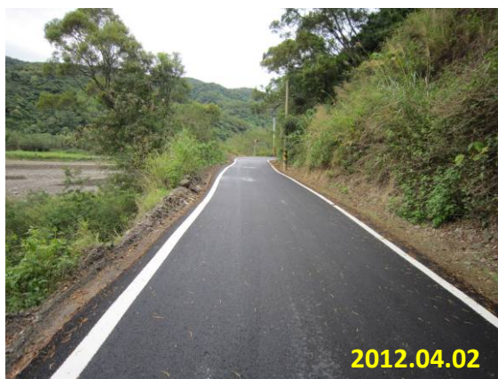
照片 5-56 瀝青混凝土鋪面 (農東達 208 -安朔及鄰近農路設施改善工程)
