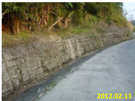
照片 5-39 上邊坡擋土牆 (農南大 031-曲溪蘆芝坑及石仔瀨溪州農路改善工程)
