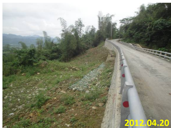
照片 5-61 下邊坡擋土牆 (農花萬 200-馬遠村馬瑞農路設施改善工程)
