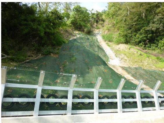
照片 5-21 掛網植生 (農中太 020-樟湖農路支線坡面處理工程)
