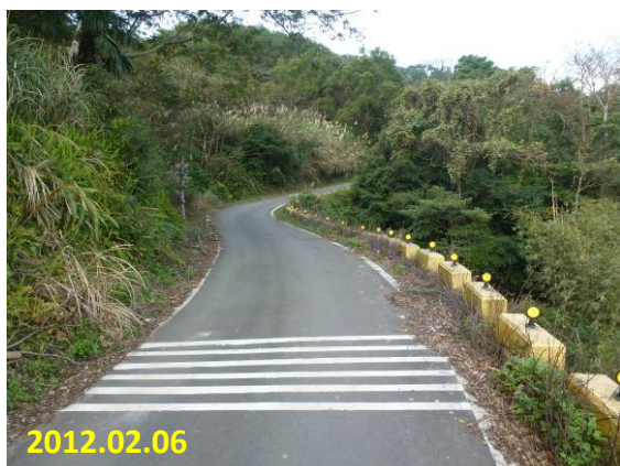
照片 5-13 阻速路面 (農竹橫 015-大山背農路設施改善工程)
