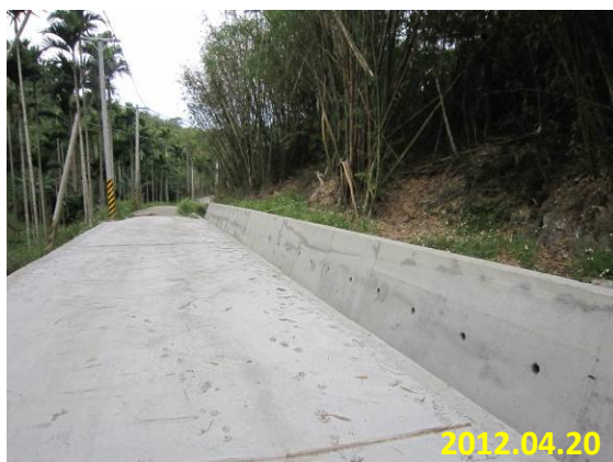
照片 5-60 上邊坡擋土牆 (農花富 057-復興二號橋上游農路設施改善工程)
