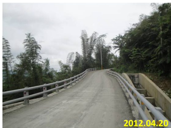
照片 5-67 鋼軌樁護欄 (農花萬 200-馬遠村馬瑞農路設施改善工程)
