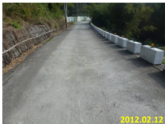
照片 5-45 水泥鋪面 (農南龍 005-福興宮農路改善工程)
