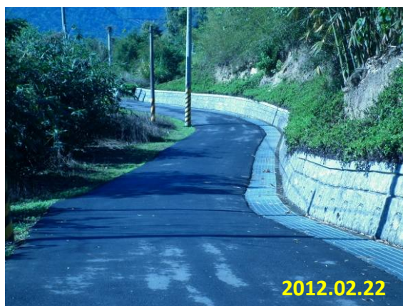
照片 5-27 上邊坡擋土牆 (農投國 030-長豐村東興道路坍方修復工程)
