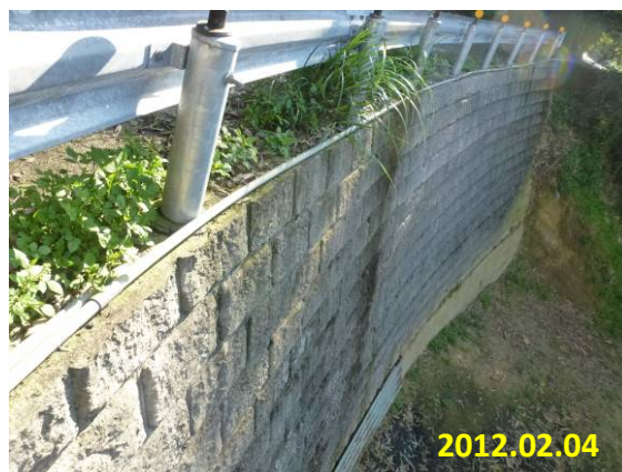
照片 5-2 下邊坡擋土牆 (農竹新 006-新竹縣轄農路安全設施加強改善工程)
