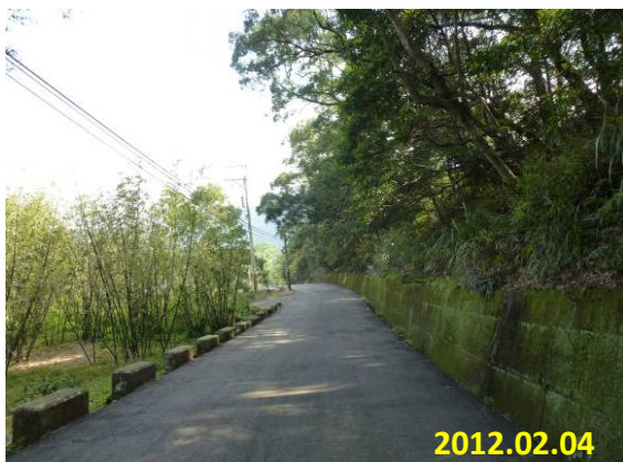
照片 5-9 瀝青混凝土鋪面 (農竹新 021-清水鹿鳴二期農路設施改善工程)
