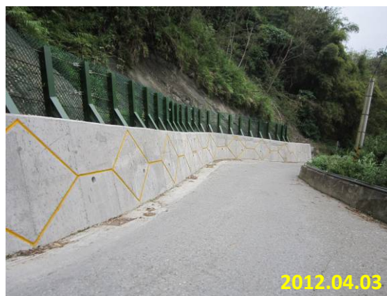
照片 5-55 防墜落石網 (農東成 021-麒麟農路改善工程)
