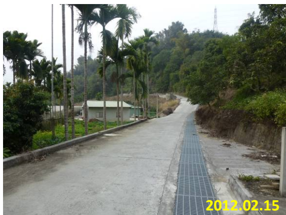
照片 5-29 縱向排水
