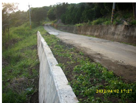
照片 5-51 下邊坡擋土牆 (農東卑 051-富源村 9、10、11 鄰農路改善工程)
