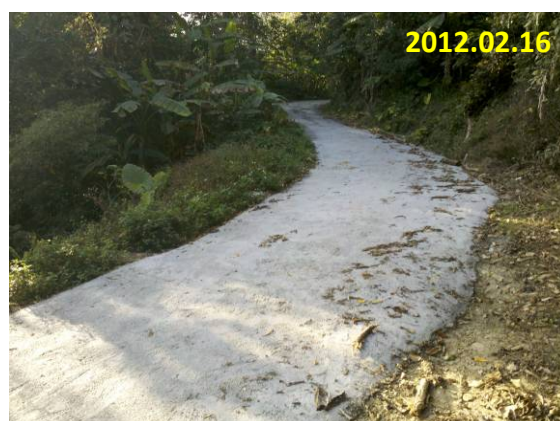
照片 5-35 水泥鋪面 (農嘉中番 020-情人橋農路改善工程)
