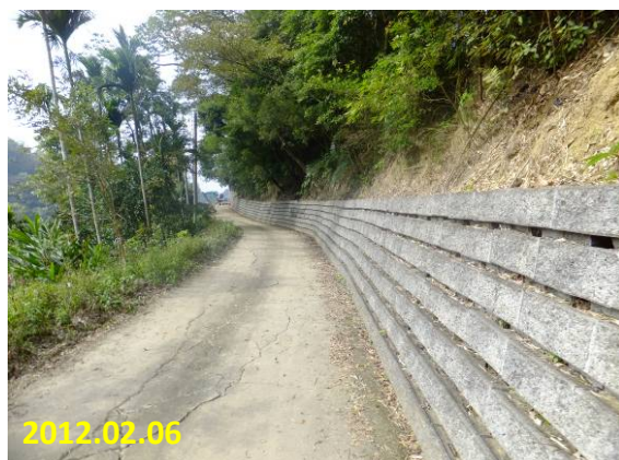
照片 5-15 上邊坡擋土牆 (農苗屋 012-農苗屋 012 支線農路改善工程)
