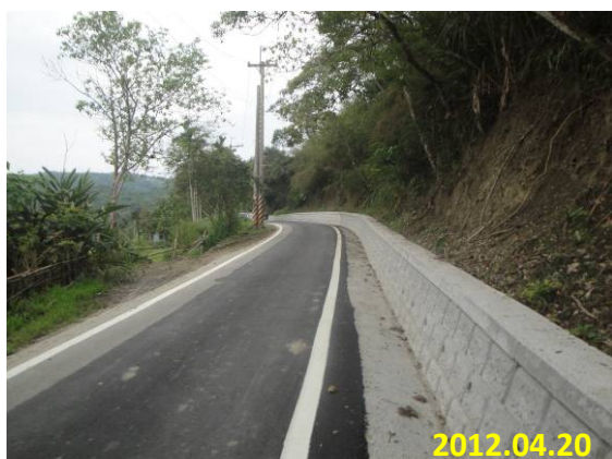
照片 5-62 縱向排水 (農花壽 061-南坑農路設施改善二期工程)
