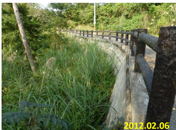
照片 5-11 仿木欄杆 (農竹埔 219-大湖村五鄰農路設施改善工程)
