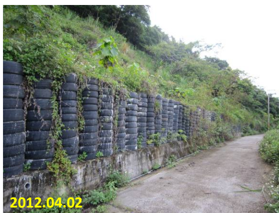
照片 5-50 上邊坡擋土牆 (農東卑市 057-農東卑 057 及鄰近農路設施改善工程)
