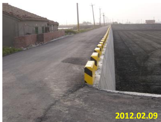
照片 5-28 下邊坡擋土牆 (農雲口 216-水井村水井寮仔至蔦松大排農路改善工程)
