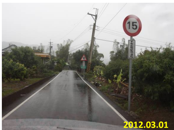
照片 5-44 瀝青混凝土鋪面 (農高內 021-溝坪農路改善工程)
