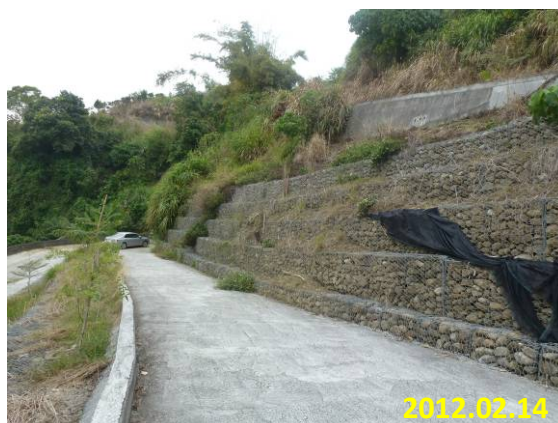
照片 5-33 石籠護坡 (農嘉崎 210-義和農路改善工程)
