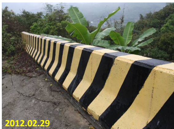
照片 5-46 護欄 (農高甲 014-甲仙鄉寶隆村嶺頂巷農路改善及維護工程)
