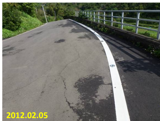
照片 5-14 標線 (農竹寶 007-寶斗 1 鄰及新城 7 鄰農路設施改善工程)
