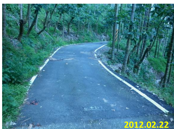
照片 5-34 瀝青混凝土鋪面 (農投國 049-第一鄰農路改善工程)
