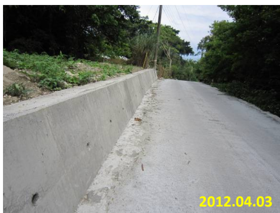
照片 5-52 縱向排水 (農東成 008-農東成 008 農路改善工程)
