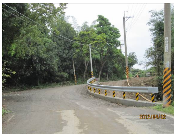
照片 5-58 鋼板護欄 (農東太 048 -金針山農路設施改善工程)
