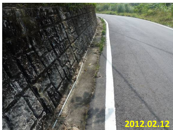
照片 5-41 L 型溝 (農南龍關 007-崎頂農路三期改善工程)
