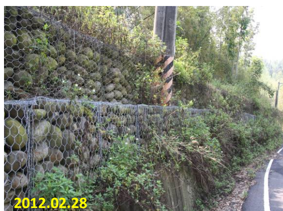
照片 5-43 石籠護坡 (農高內 041-瑞山赤銅湖農路改善工程)
