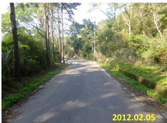
照片 5-23 瀝青混凝土鋪面 (農苗公 015-打鹿坑福德農路及東安農路改善工程)
