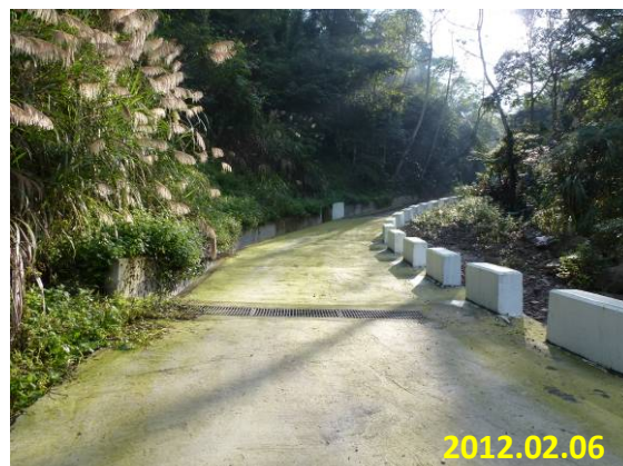
照片 5-10 水泥鋪面 (農竹埔 019-南坑大湖地區農路設施改善工程)
