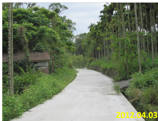
照片 5-57 水泥鋪面 (農東池 055 -農東池 055 及鄰近農路設施改善工程)
