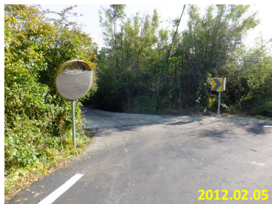
照片 5-26 反光鏡 (農苗西 011-榕樹嶼閩水窩產業道路改善工程)
