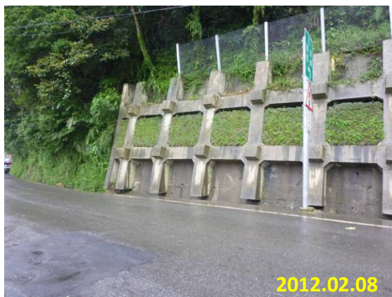
照片 5-7 固定型框植生
