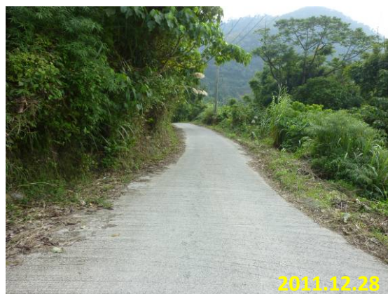
照片 5-24 水泥鋪面 (農中太新 021-石岩農路改善工程)
