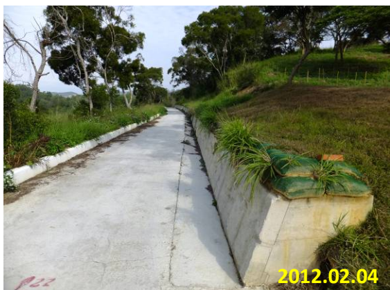
照片 5-17 縱橫向排水 (農苗通 026-城圳農路改善工程)
