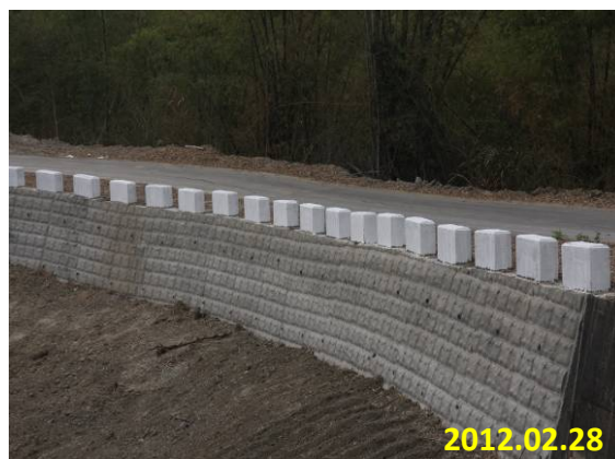
照片 5-40 下邊坡擋土牆 (農高田 015-鹿南巷鹽湖崙農路改善工程)
