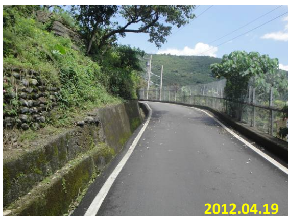
照片 5-65 瀝青混凝土鋪面
