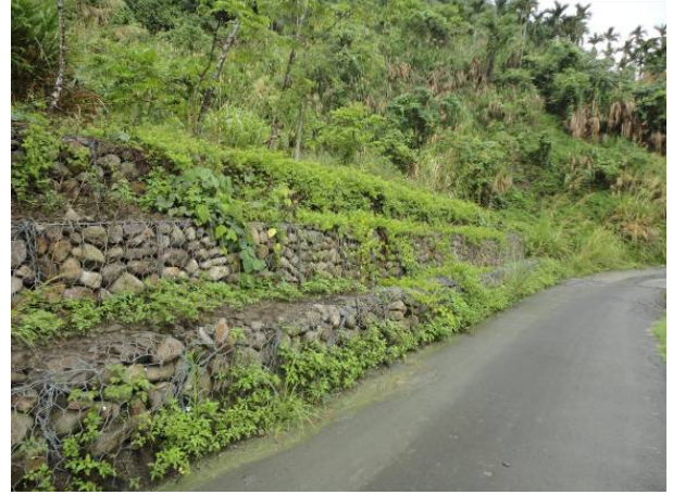
十八份道路旁崩塌地處理工程 95ESC-004
