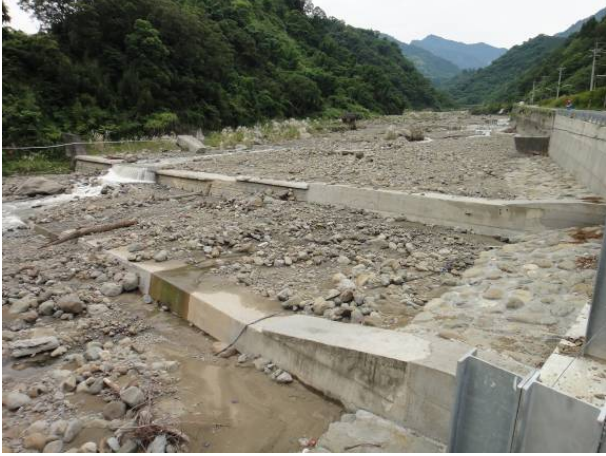
羅娜野溪整治工程 96S-WF-3-M33-002
