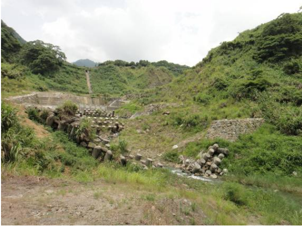
長安橋上游崩塌地災害復建工程 98WS2018-003
