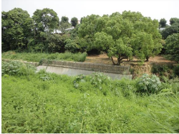
三塊厝崩塌地整治 2 期工程 99S-WF-3-M04-008
