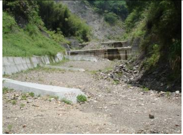
豐丘明隧道口野溪整治工程 97S-WF-3-M05-004
