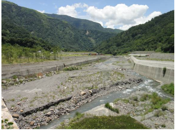
南豐橋上下游整治工程 98S-ADE-01-3-024
