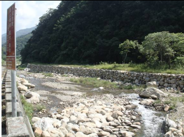
玉崙溪下游整治工程 99S-SC-3-M03-001
