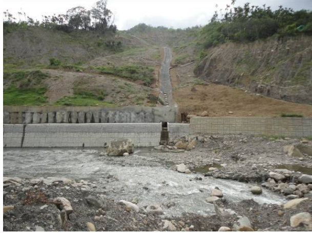
大旗崩塌地災害復建工程 98S-WF-3-M10-008
