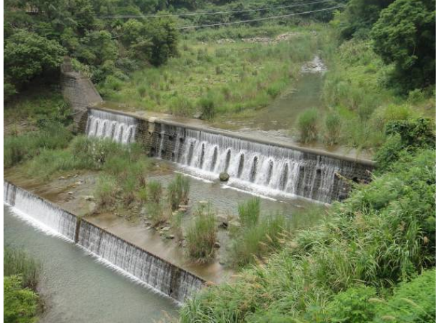
中興橋下游野溪復建工程 97WS3031-001
