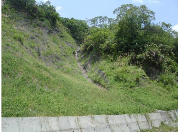
豐丘明隧道口野溪整治工程 97S-WF-3-M05-004
