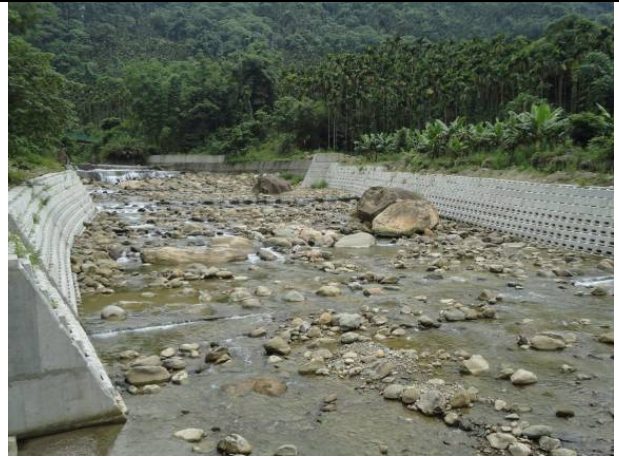
粗坑橋上游野溪整治工程 99S-SC-3-M02-013
