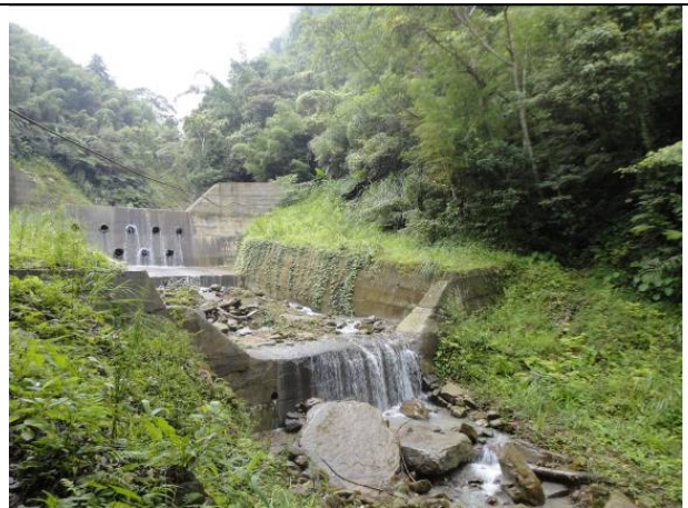
深坑一號橋上游野溪災害復建工程 98S-WF-3-M10-007
