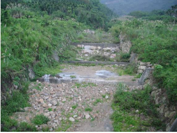
二部坑福德橋上游整治工程 98S-WF-3-M04-001
