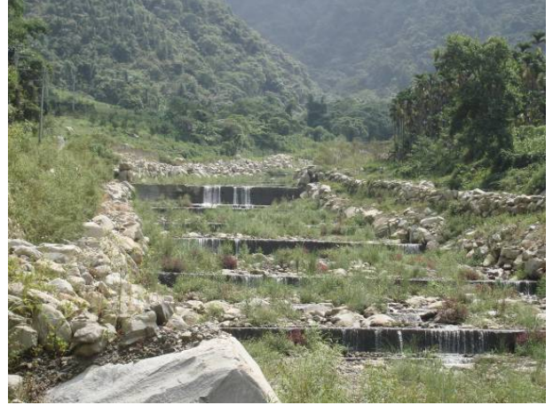
潭南一號橋上游二期治山防洪工程 95-WS-3-M09-077
