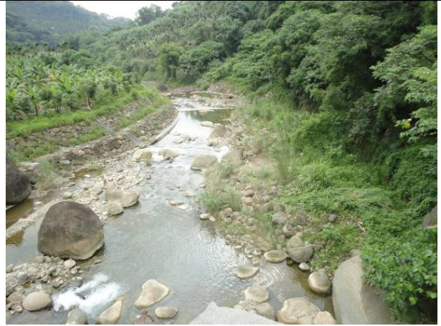
粗坑橋下游河道整治一期工程 97S-SC-3-M01-001
