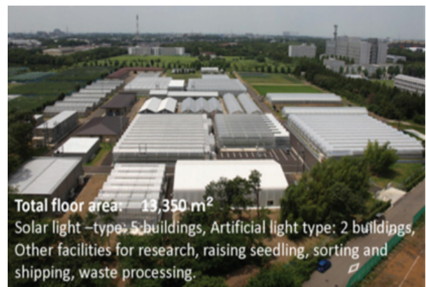
圖 18. 日本千葉大學植物工場配置圖，其中有 5 棟為陽光利用型植物工廠及兩棟人工光源型 (Maruo Toru, Chiba University, Japan)
