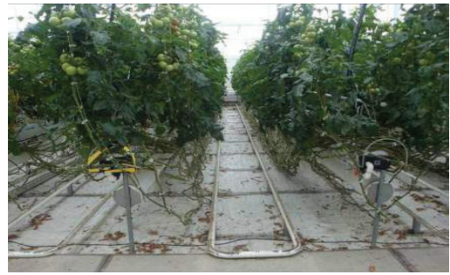
圖 11.軌道式加溫管路
