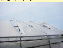
▲塑膠膜從壓條處破裂情況
