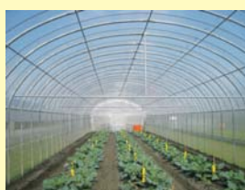
▲設施內部橫向支撐增加結構剛性
