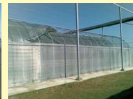
▲塑膠膜被吹破情況
