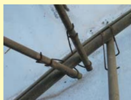
▲彈簧夾老舊生鏽情況，管材與塑膠膜接觸有摩擦破損可能
