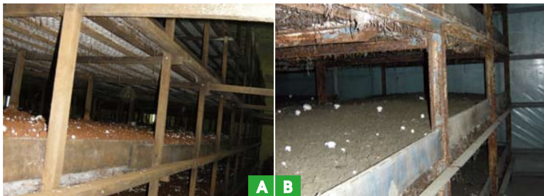
圖二、A. 傳統菇舍噴pu改裝成環控菇舍；B. 以保麗龍片保溫方式搭建之環控菇舍。
