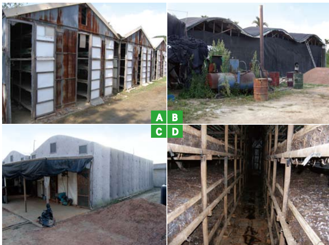
圖一、傳統菇舍 A. 簡易鐵皮屋搭建之菇寮；B. 簡易黑網搭建之菇寮；C. 塑膠棉布搭建之簡易菇寮；D. 傳統菇舍內部之床架。
