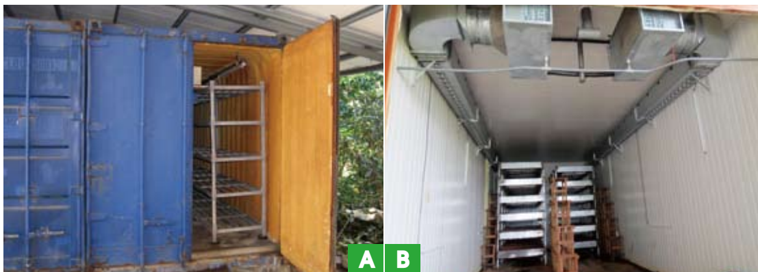
圖三、A. 貨櫃改裝之環控栽培菇舍；B. 以保溫庫板搭建之環控栽培菇舍。
