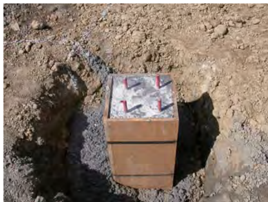
▲所謂固定基礎農業設施，簡單區分方式為有無混凝土基礎立柱者稱之
