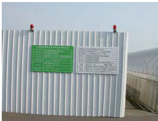
▲取得農業設施容許使用，應於六個月內向建築主管機關提出申請建築執照
