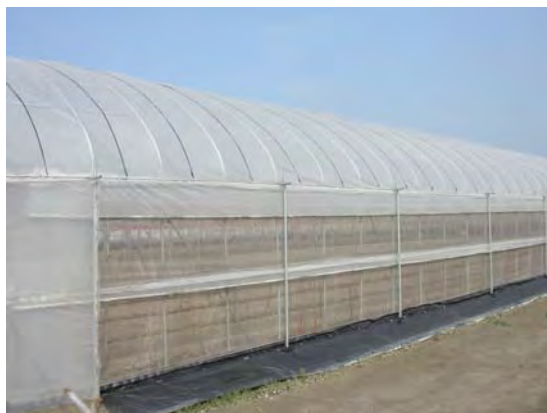
▲搭建無固定基礎之臨時性與農業生產有關之設施，除另有規定者外，得免申請容許使用
