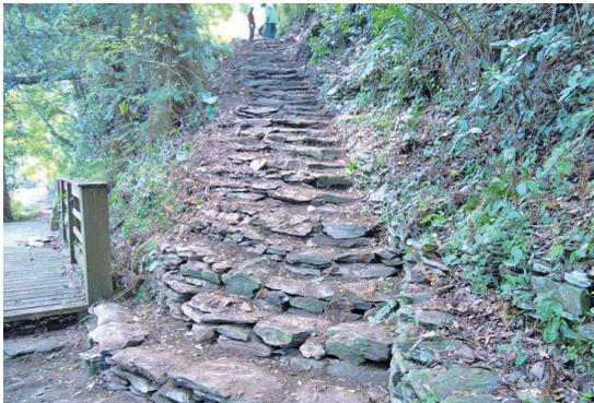
以部落傳統工法鋪設的砌石步道
