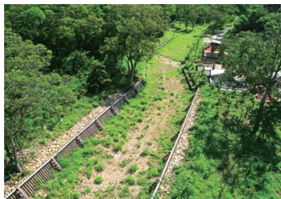
合和集水區上游野溪整治工程獲金質獎榮耀
