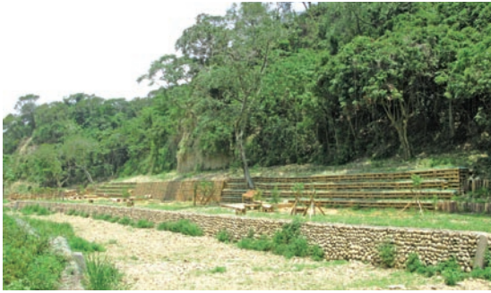
八卦山保安林地水患治理第一期整治工程-優良工程獎
