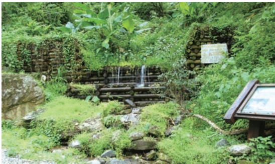
白鮑溪三期整治加強工程-優良工程獎
