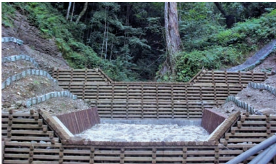
荖濃溪事業區71林班崩塌地處理工程-優良工程獎
