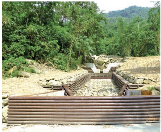
大埔區第80林班野溪整治工程-優良農建佳作
