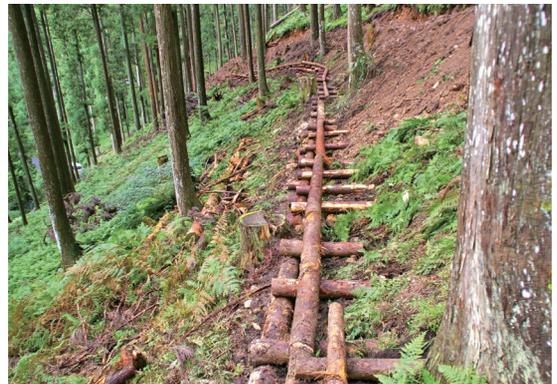
照片2 斜面坡超過35度之地點，須配合架設原木組等構造物。
