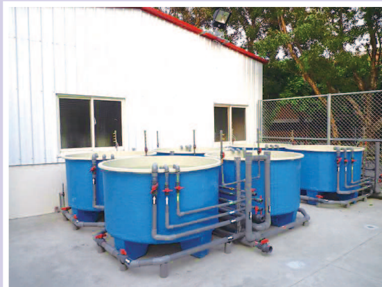
完成設備安裝試運轉申報外觀
