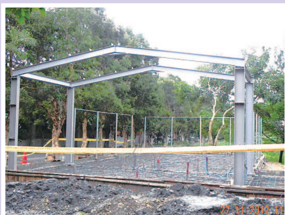
版鋼筋組立、水電配管、鋼構安裝
