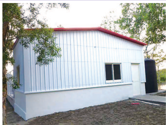
完成工程竣工及設備試運轉申報外觀
