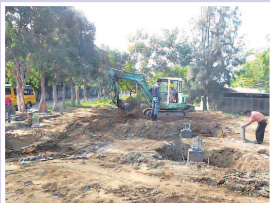
整地、放樣、開挖、基礎版底筋及柱組立
