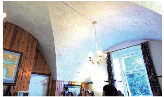
教師休息室頂端的拱形屋頂，是為了防止大雪壓壞屋頂而設計。
