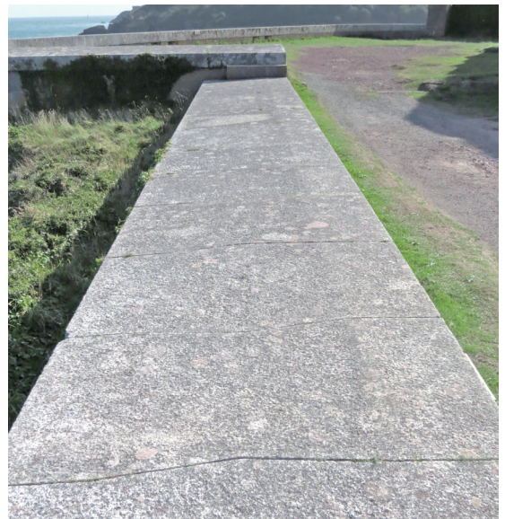
石牆的石磚並非十分方正，為了防止受砲彈攻擊，城牆倒塌而設計的。
