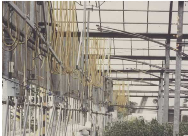
圖十六、多連棟溫室中裝設單棟型噴霧系統時噴架與管路數量可觀，累加而成本昂貴
