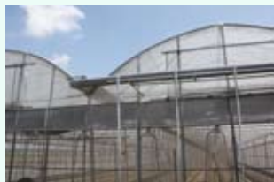
▲連棟溫室之雨水收集情形
