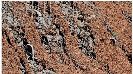
噴植基材膠結力低或施工初期豪雨造成基材滑落情形
