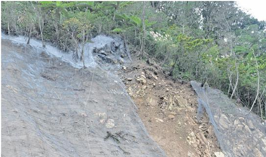
坡度陡峭且坡長較長地區施工時常致網材脫落情形
