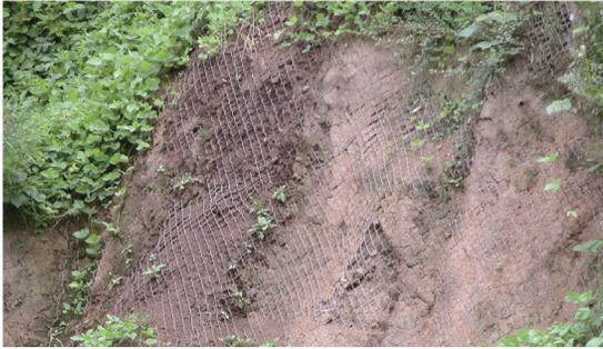
網材伏貼性不佳造成噴植基材脫落
