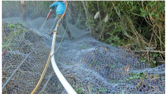
坡頂需有混凝土噴漿排水溝穩定上邊坡網材
