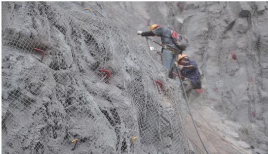
網材錨釘固定施工情形
