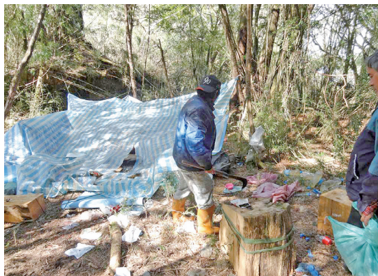
丹大事業區第10林班拆除獵寮情形
