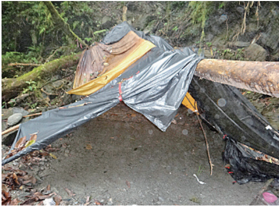
現場拆除簡易獵寮
