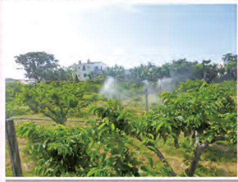
圖 3. 微霧噴頭果園安裝及加濕情形
