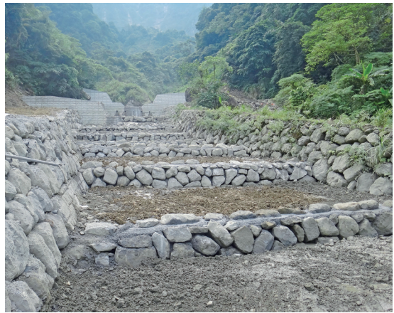
三重溪橋上下游整治，利用淤積石材施作砌石護岸、固床工，防止河岸兩側沖刷崩塌及溪床淘刷，保護橋梁。(攝影/施仁華)
