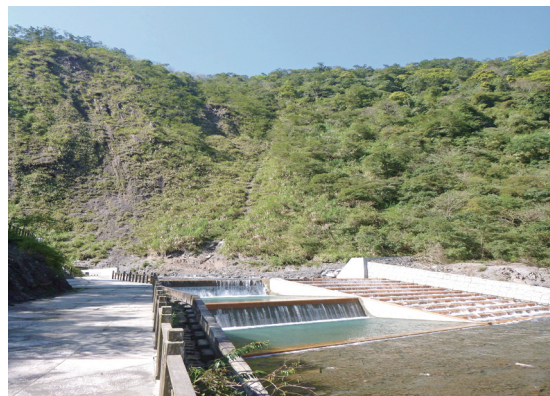
多望溪鳩之潭段整體治理工程，施作多種型式魚道，提供魚類洄游，保育溪流生態。(攝影／林志明)
