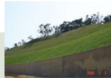
科學園區邊坡穩定設施
