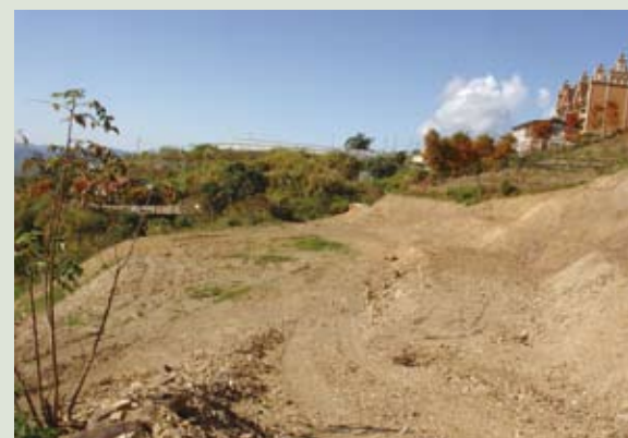
南投違規案件開挖整地
