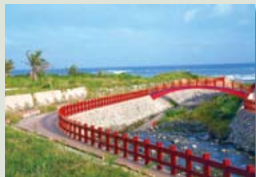
台東東河鄉北郡界貝橋野溪 整治週邊綠化
