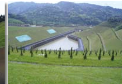
基隆市棄土場水土保持設施
