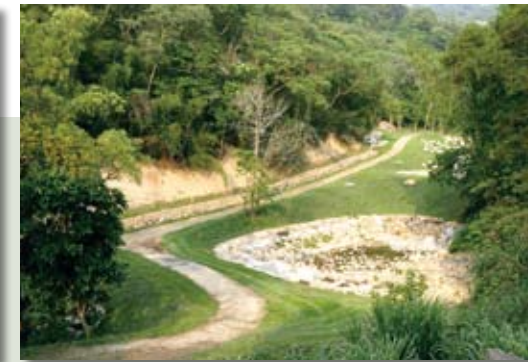
苗栗縣通霄鎮芎蕉坑整治三期水土保持工程
