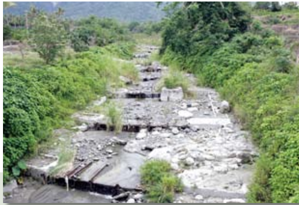
台東縣東河鄉羊橋防砂五期工程
