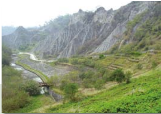
台南縣龍崎鄉--龍崎工廠旁緩衝帶及環境綠美化處理
